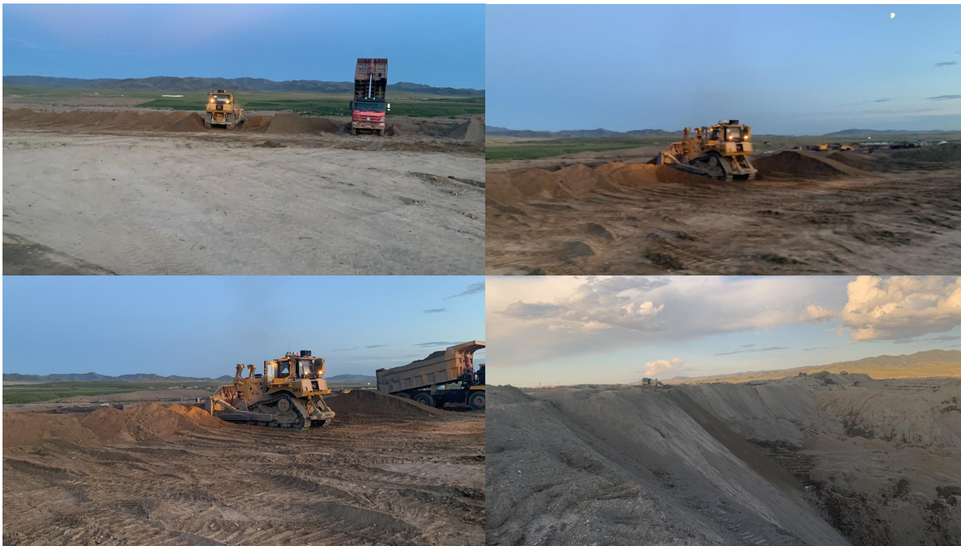
Зураг 16. Техникийн нөхөн сэргээлт хийж буй байдал
