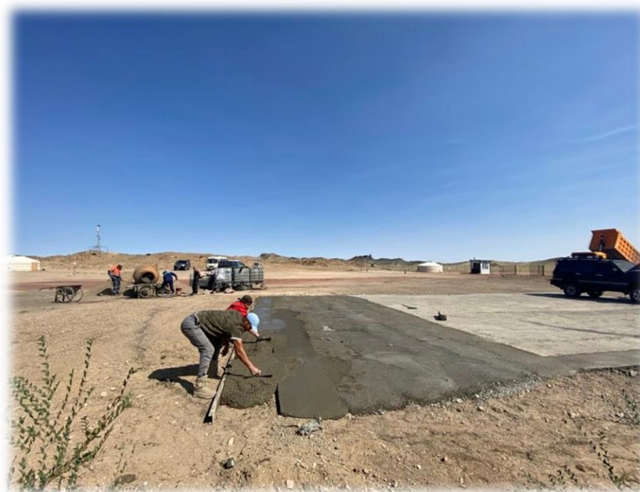
Зураг 24. Уурхайн тосгоны техник парклах талбайг бүрэн бетондсон.
