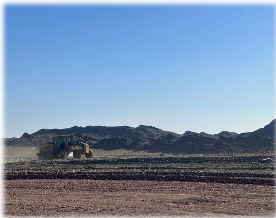
Зураг 15.Зам засвар хийж буй байдал.
