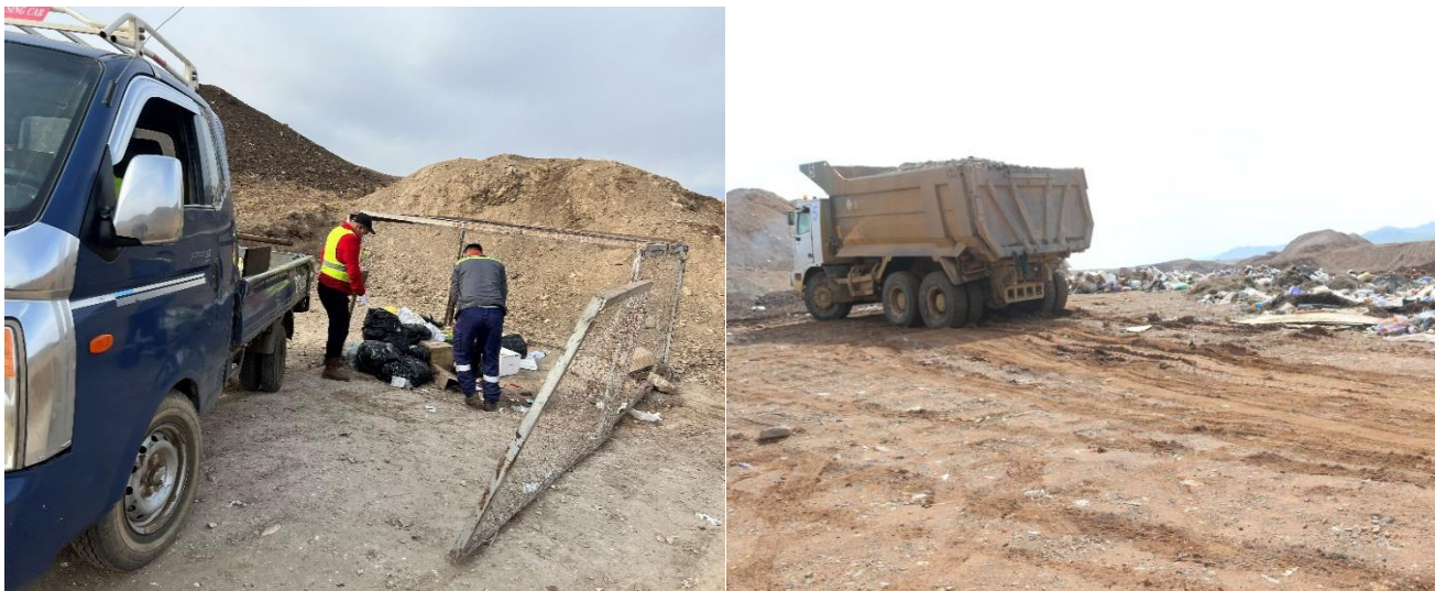
Зураг. 37 Ахуйн хог хаягдлыг нэгдсэн цэгт ачиж буй зураглал.
