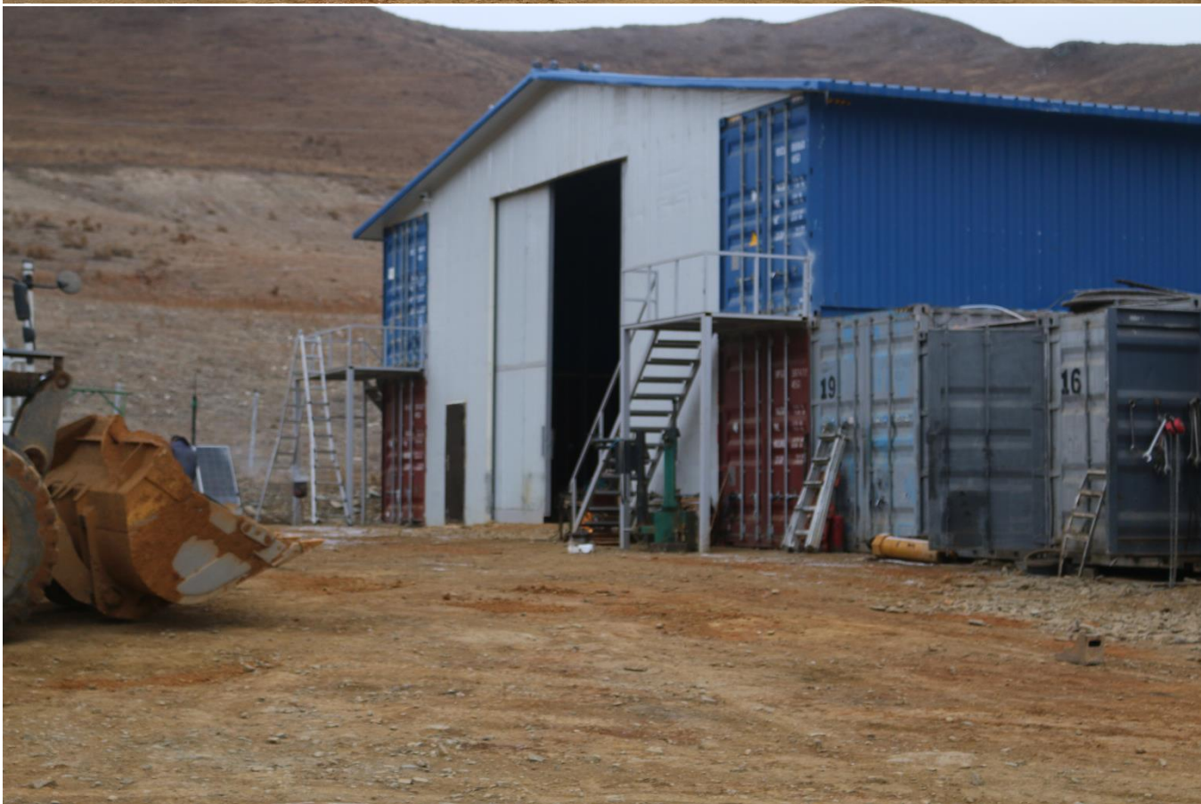
Зураг.10 Засварын талбайд үйлчилгээ хийж буй ажлын явц
