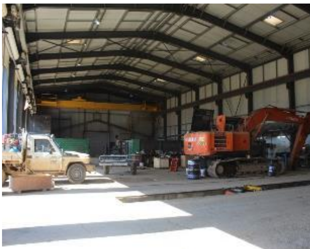
Зураг 10. Засвар үйлчилгээний цементилсэн талбай
