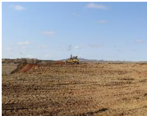
Зураг 17. Дотоод овоолго хэлбэржүүлж нөхөн дүүргэлт хийж буй байдал
