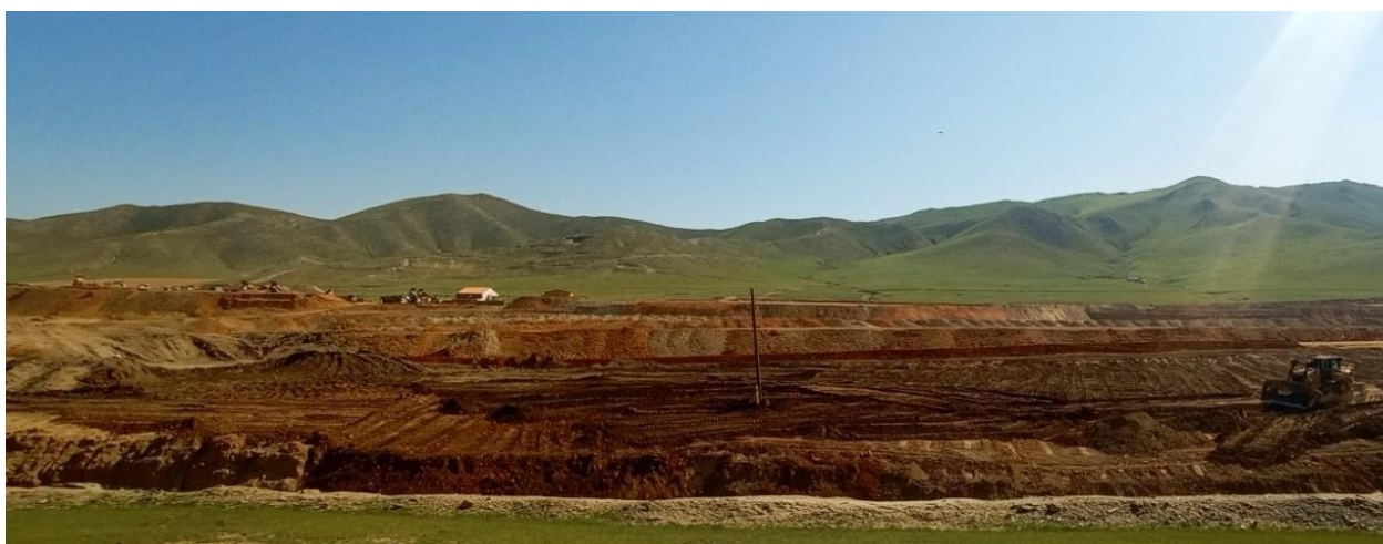
Зураг.17 Техникийн нөхөн сэргээлт дотоод овоолгоор нөхөн дүүргэлтийн ажил 11 га 6 сар
