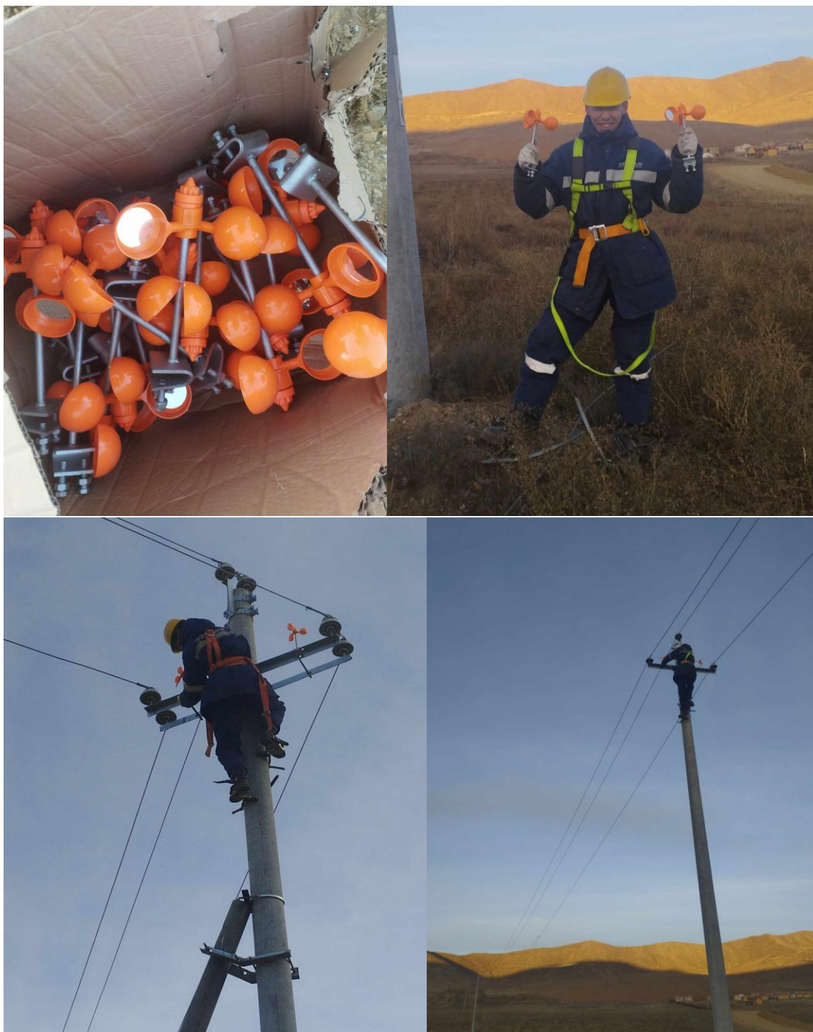
Зураг. 14 Уурхайд байрлах нийт 20 ширхэг тулгуур дээр шувуу үргээгч суурьлууллаа
