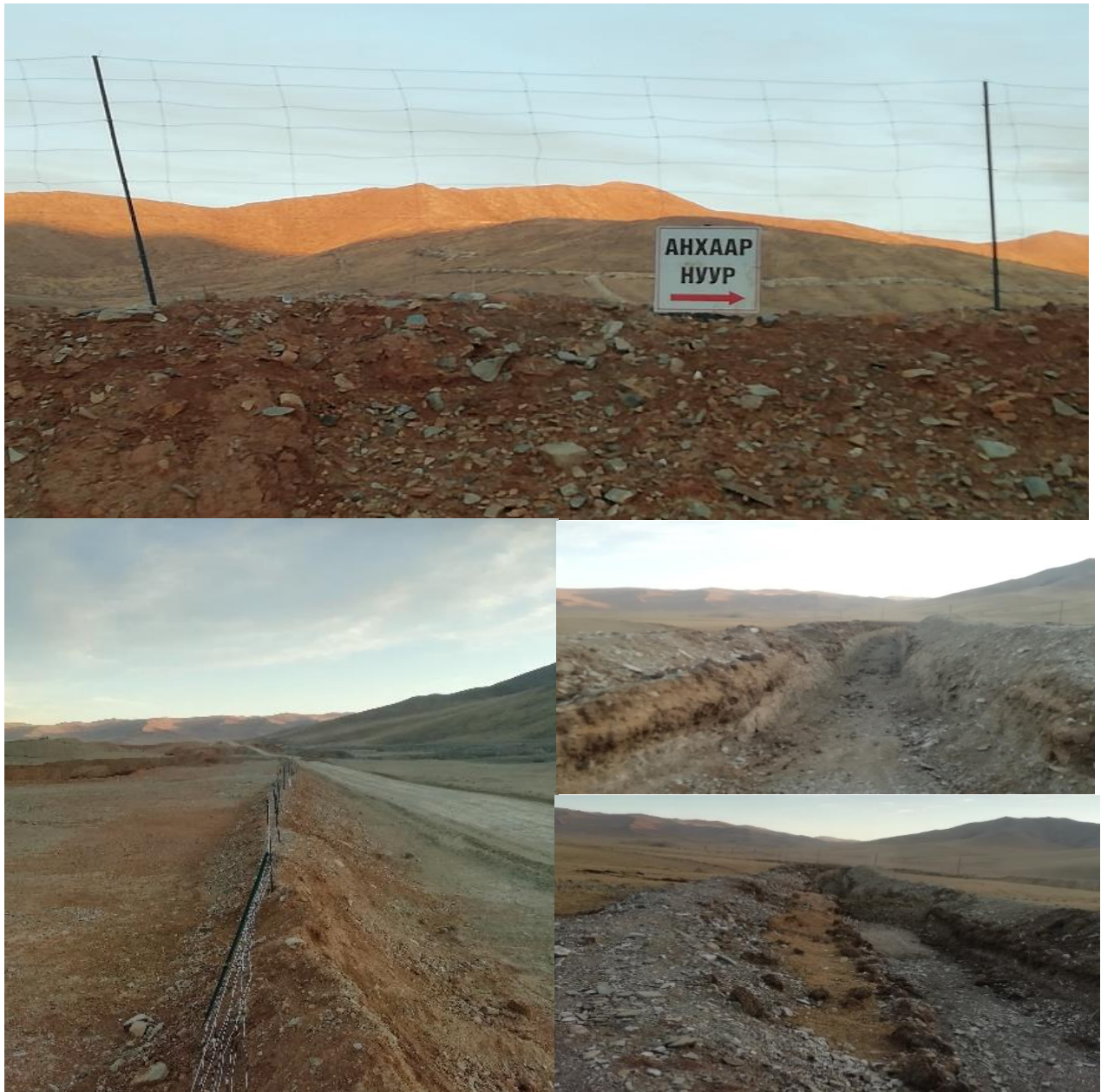
Зураг.15 Хашаа хамгаалалт хийсэн байдал
