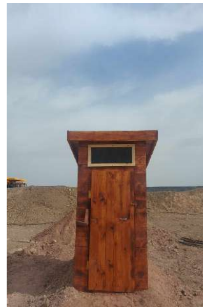
Зураг 9. Хөрс орчны бохирдол үүсгэсэн стандартын бус нүхэн жорлогийн оронд Эко соруулдаг 00 болгон өөрчиллөө
