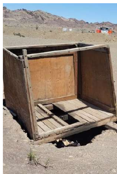
Зураг 9. Хөрс орчны бохирдол үүсгэсэн стандартын бус нүхэн жорлогийн оронд Эко соруулдаг 00 болгон өөрчиллөө
