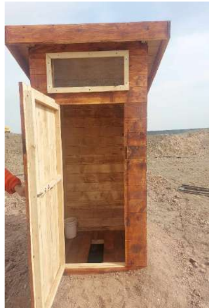
Зураг 9. Хөрс орчны бохирдол үүсгэсэн стандартын бус нүхэн жорлогийн оронд Эко соруулдаг 00 болгон өөрчиллөө
