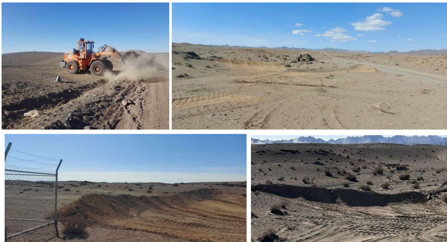
Зураг 6. Нүүрс тээврийн машины жолооч нар жижиг тэрэгээр уурхайд ирэхдээ олон салаа зам үүсгэж явсан хэсгүүдийн замыг хааж зориулалтын зогсоол хийж машинуудыг байршуулдаг болов.
