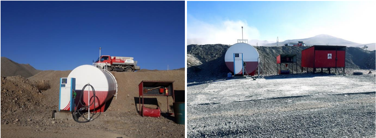
Зураг 4. ШТС-ийн талбай орчмыг бетондсон байдал
