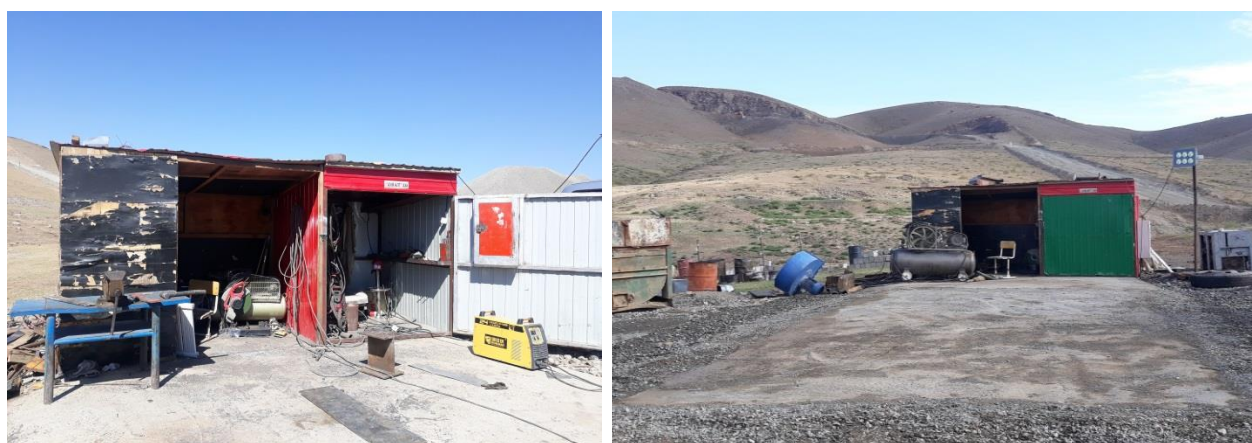
Зураг 7. Засварын газрын талбайн хөрс бохирдохоос сэргийлж бетондсон
