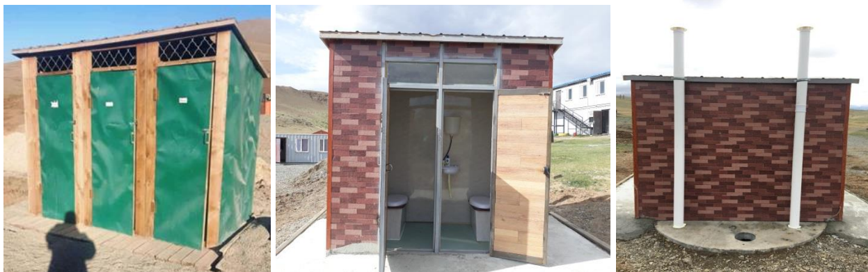
Зураг 26 . Нүхэн жорлонг халж, MNS 5924:2015 стандартын шаардлагад нийцсэн нүхэн жорлонг байршуулан ажиллаж байна.
