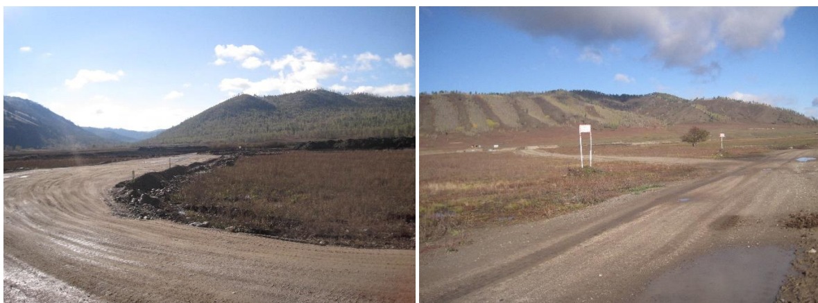
Зураг 3. Замын тоосжилтыг дарсан байдал
