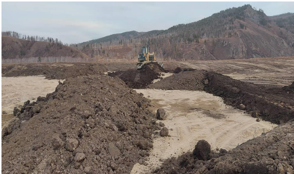
Зураг 5. Эфель гаалийн дүүргэлт хийж шимж хөрсөөр хучих явц
