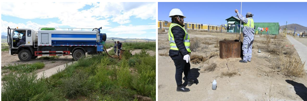
Зураг № 2 - 10. Бохир ус соруулж буй байдал
