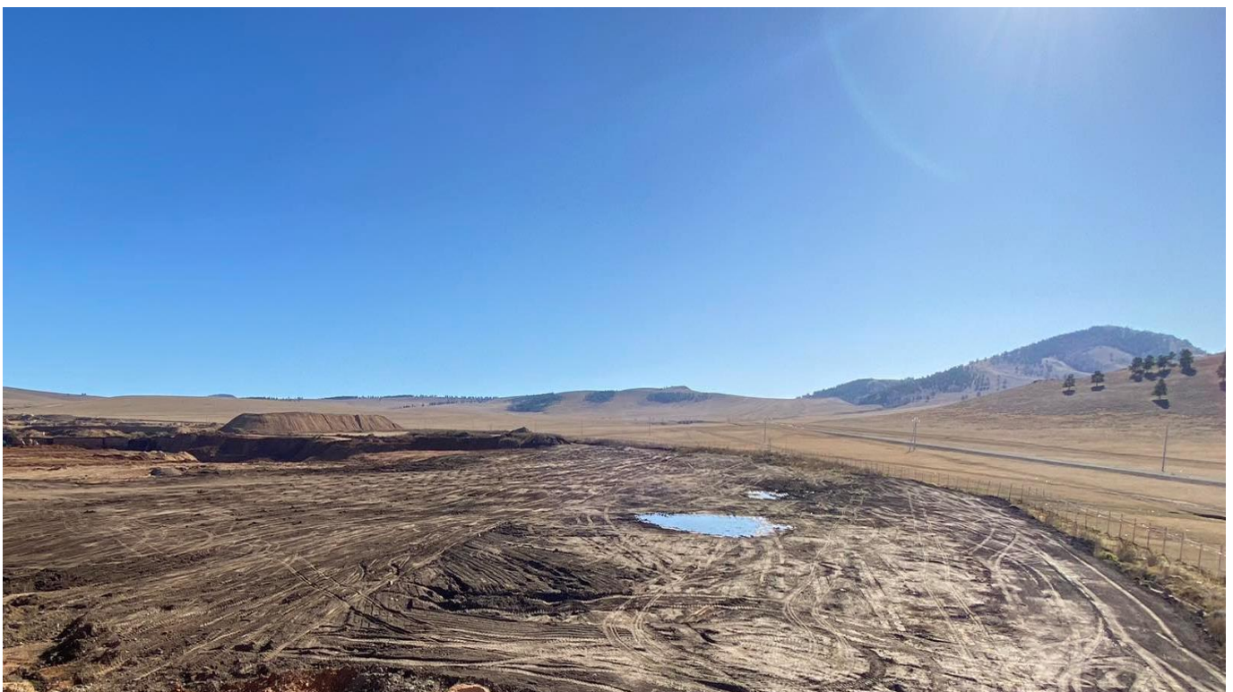
Зураг-7. Техникийн нөхөн сэргээлт хийж, биологийн нөхөн сэргээлтээр модны суулгац тариалахаар бэлтгэсэн талбай.
