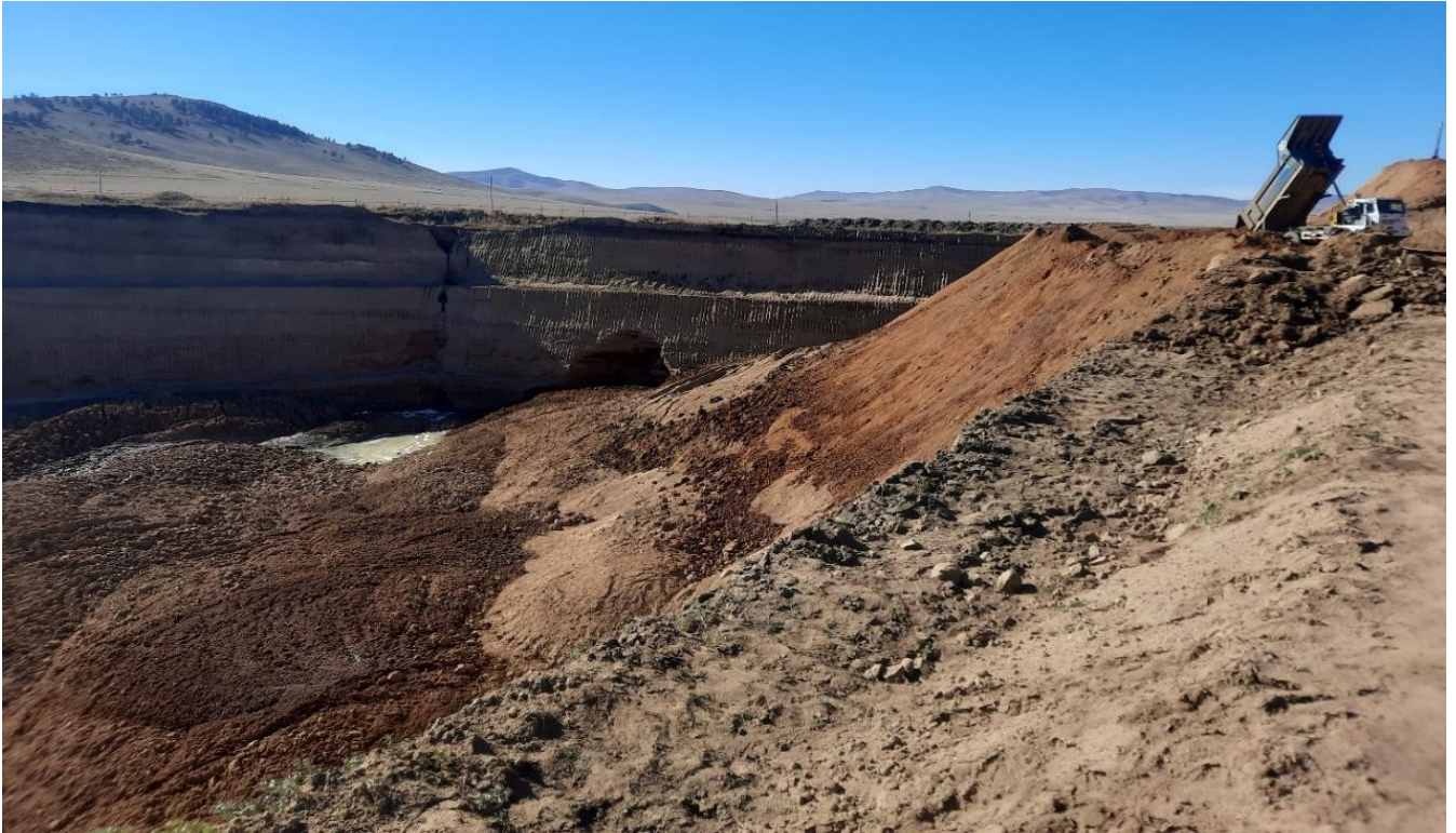
Зураг-4 . В-1 блокт үүссэн орон зайд нөхөн дүүргэлт хийж байгаа байдал
