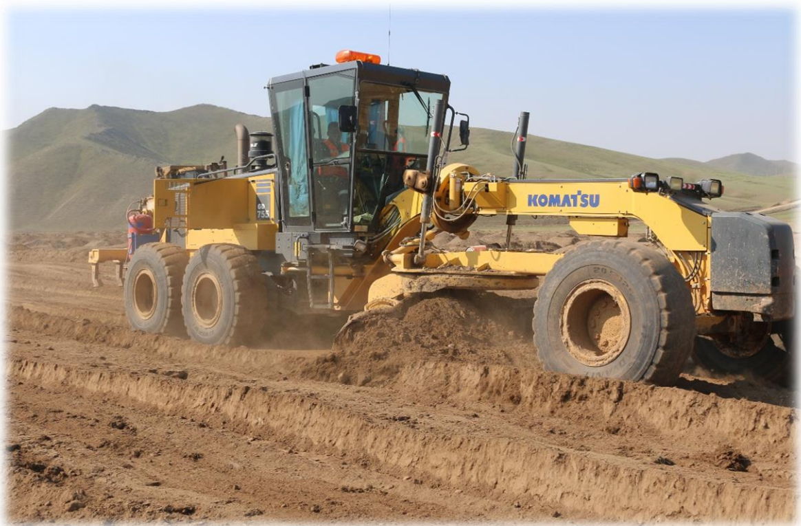
Зураг № 13 Автогрейдер болон бульдозероор хэлбэржүүлэлтийн ажил явагдаж байна.
