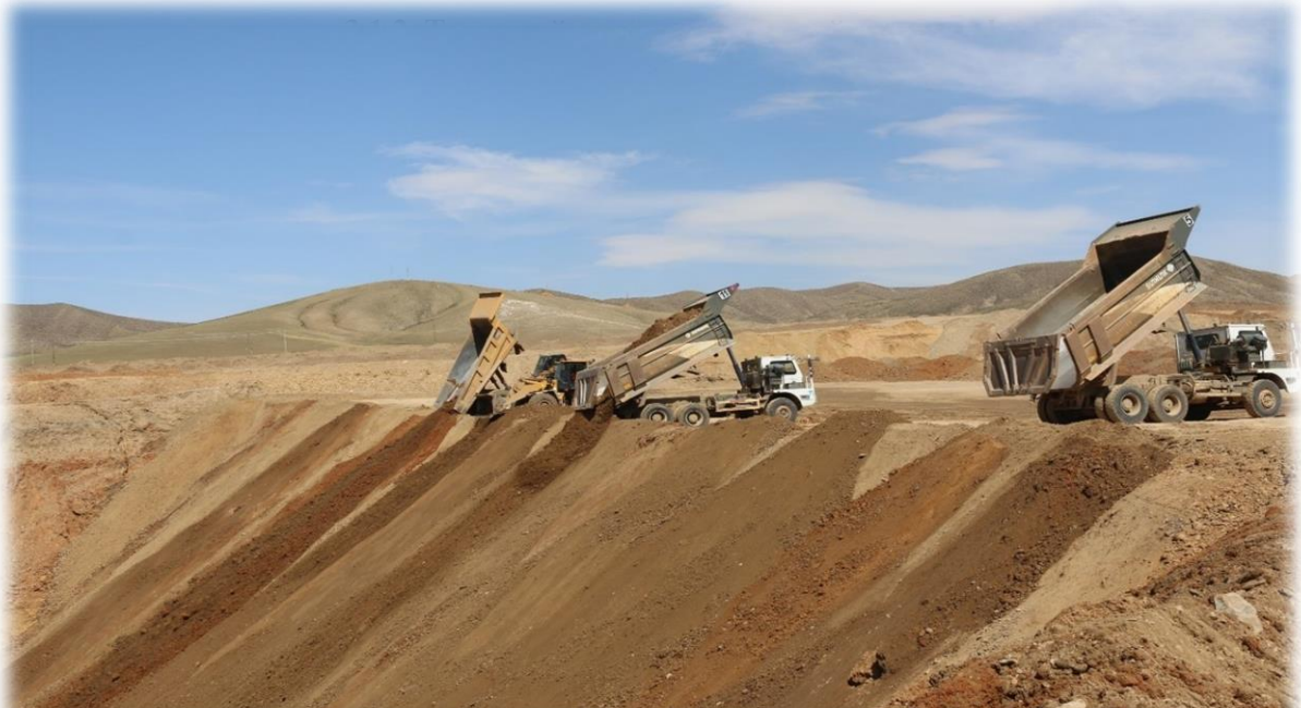
Зураг №.12 Техникийн нөхөн сэргээлт эхэлж байх үе /дотоод овоолгоор дүүргэлтийн ажил хийгдэж байна./
