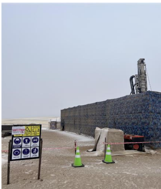
Зураг 26 Өрмийн талбайд ХАБ-ийн тэмдэг тэмдэглэгээ байршуулсан байдал
