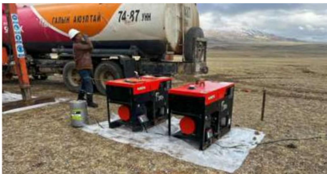
Зураг 5 Генераторын доод хэсэгт хөрс хамгаалах пластик уут дэвссэн байдал
