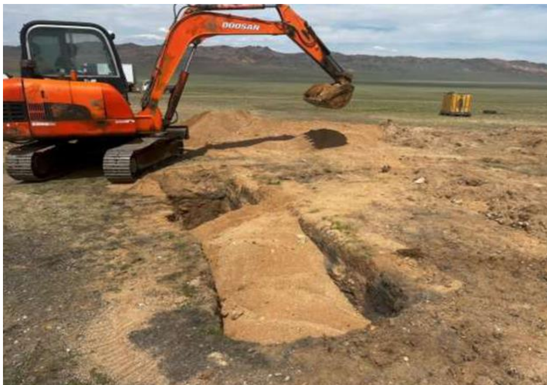
Зураг 8 Өрмийн цооногийн шинэгний хаягдлын техникийн нөхөн сэргээлт хийгдэж буй байдал
