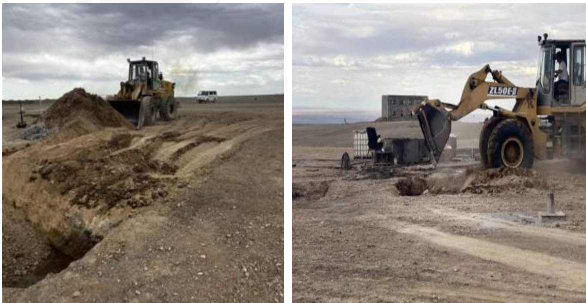
Зураг 14 Цооногуудын техникийн нөхөн сэргээлт хийгдэж буй байдал
