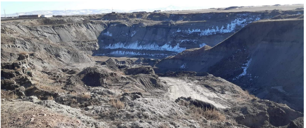
Зураг 3.7. Уурхайн дотоод зам талбайг түрж тэгшилсэн байдал
