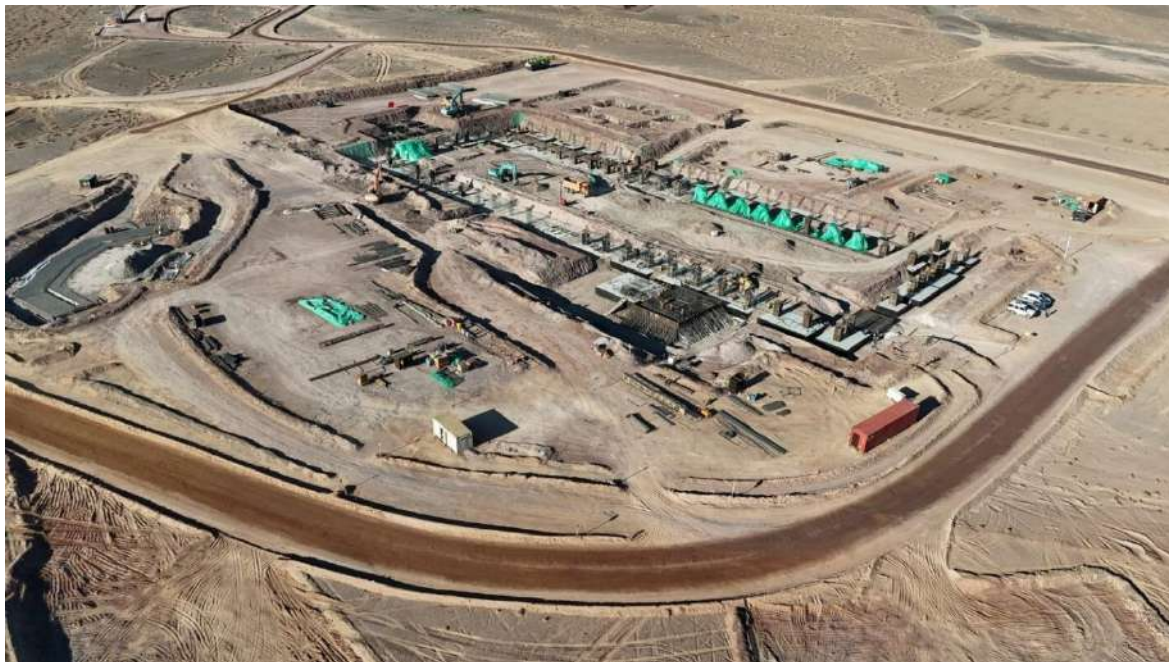
Зураг 8. Баяжуулах үйлдвэрийн барилгын явц
