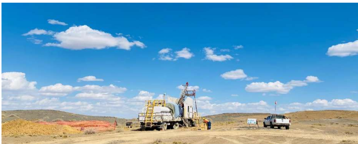
Зураг 9. Хайгуулын цооног өрөмдөж байгаа үеийн байдал
