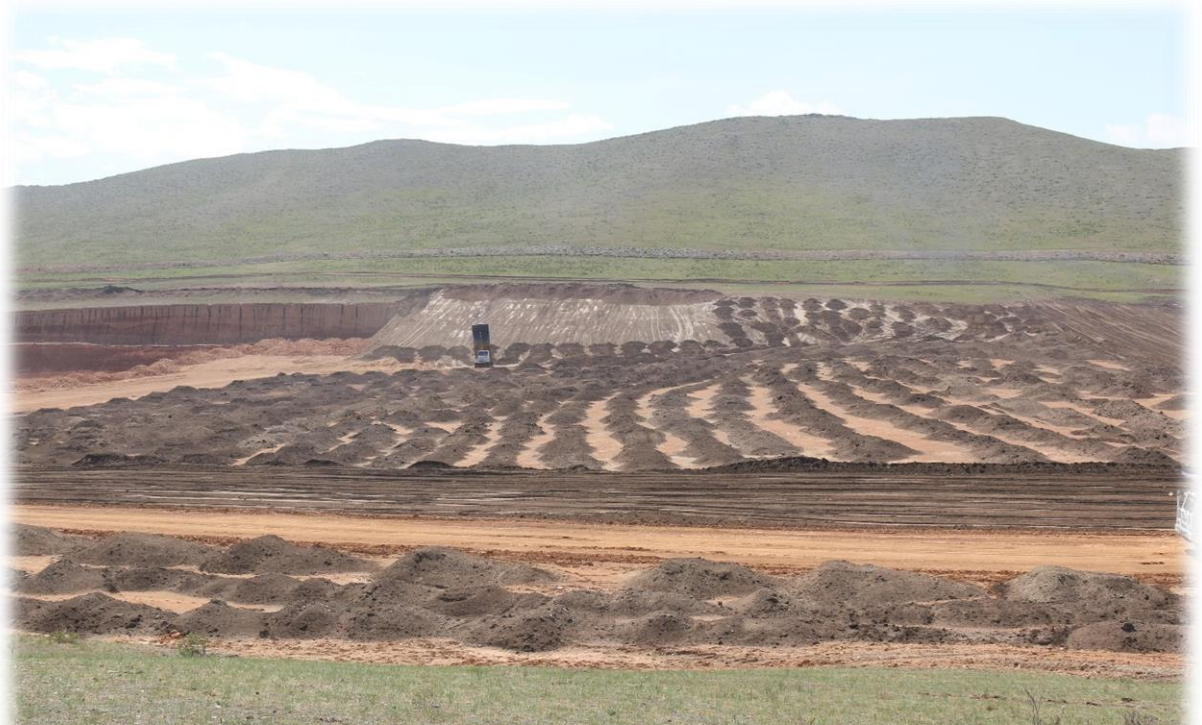
Зураг № 13 Автогрейдер болон булдозероор хэлбэржүүлэлтийн ажил явагдаж байна.
