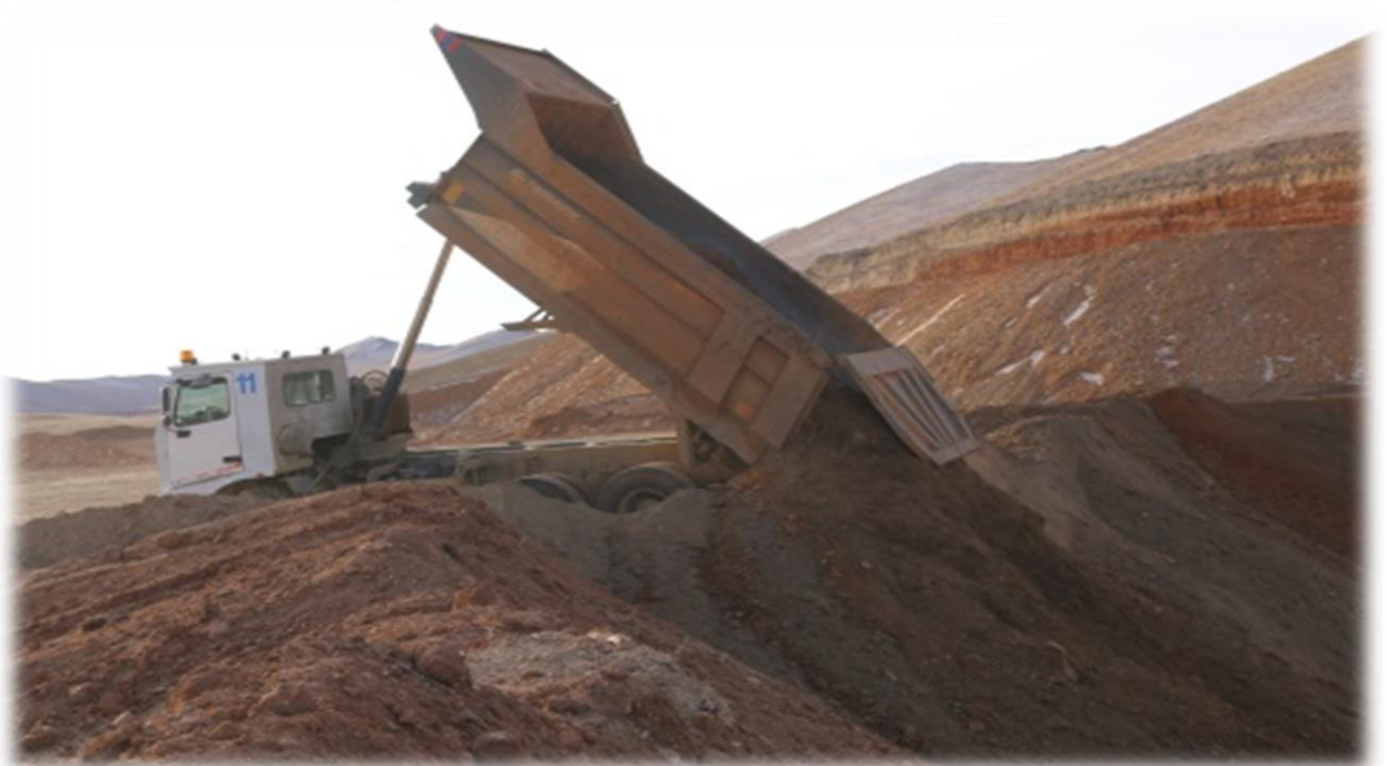
Зураг №.12 Техникийн нөхөн сэргээлт эхэлж байх үе /дотоод овоолгоор дүүргэлтийн ажил хийгдэж байна./
