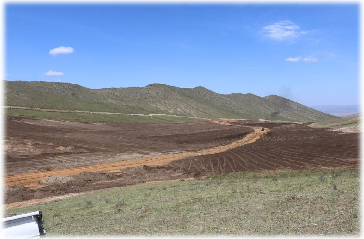
Зураг №.14 Автогрейдер, Бульдозероор тэгшилж хэвгийжүүлэн биологийн нөхөн сэргээлт хийхэд бэлэн болсон талбай.
