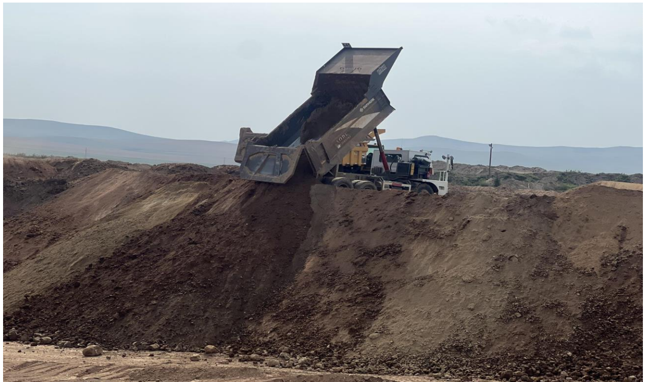
Зураг 7. Дотоод овоолгоор нөхөн дүүргэлт хийж буй ажлын явц
