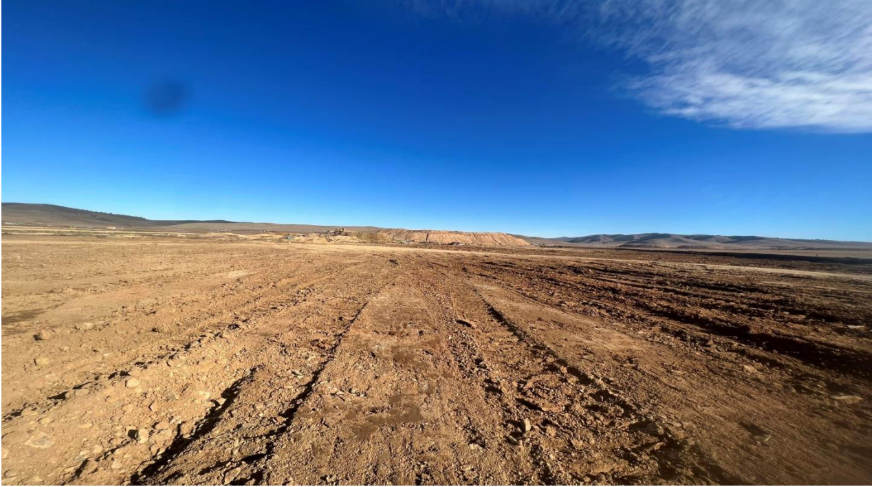
Зураг 8. Нөхөн дүүргэлт хийж тэгшилсэн талбай
