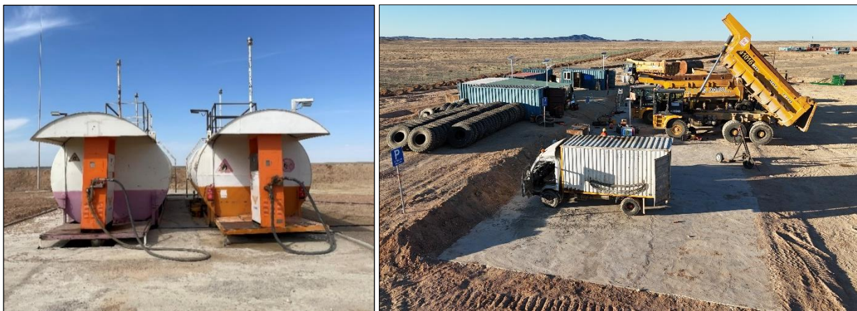
Зураг№ 13. Засварын газар, ШТС, Шатах тослох материалын агуулах хөрс бохирдохоос сэргийлж цементэн хучилттай болгосн байдал
