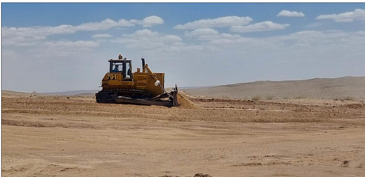
Зураг № 18. Уурхайн технологийн замын шимт хөрс хуулалт
