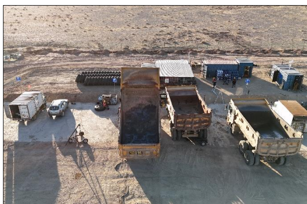
Зураг№25. ШТС, Засварын газар ШТМ-аар хөрс бохирдохоос сэргийлж талбайг цементлсэн байдал
