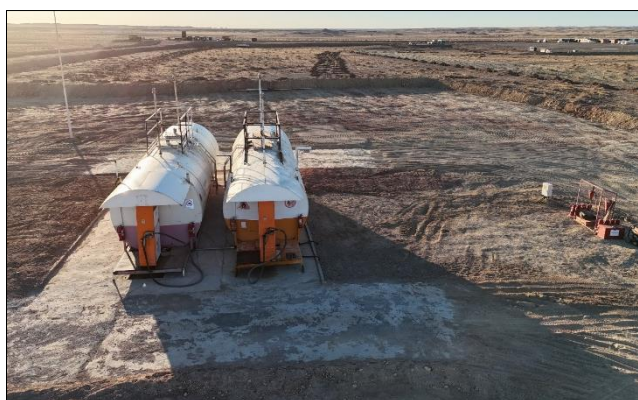
Зураг№25. ШТС, Засварын газар ШТМ-аар хөрс бохирдохоос сэргийлж талбайг цементлсэн байдал
