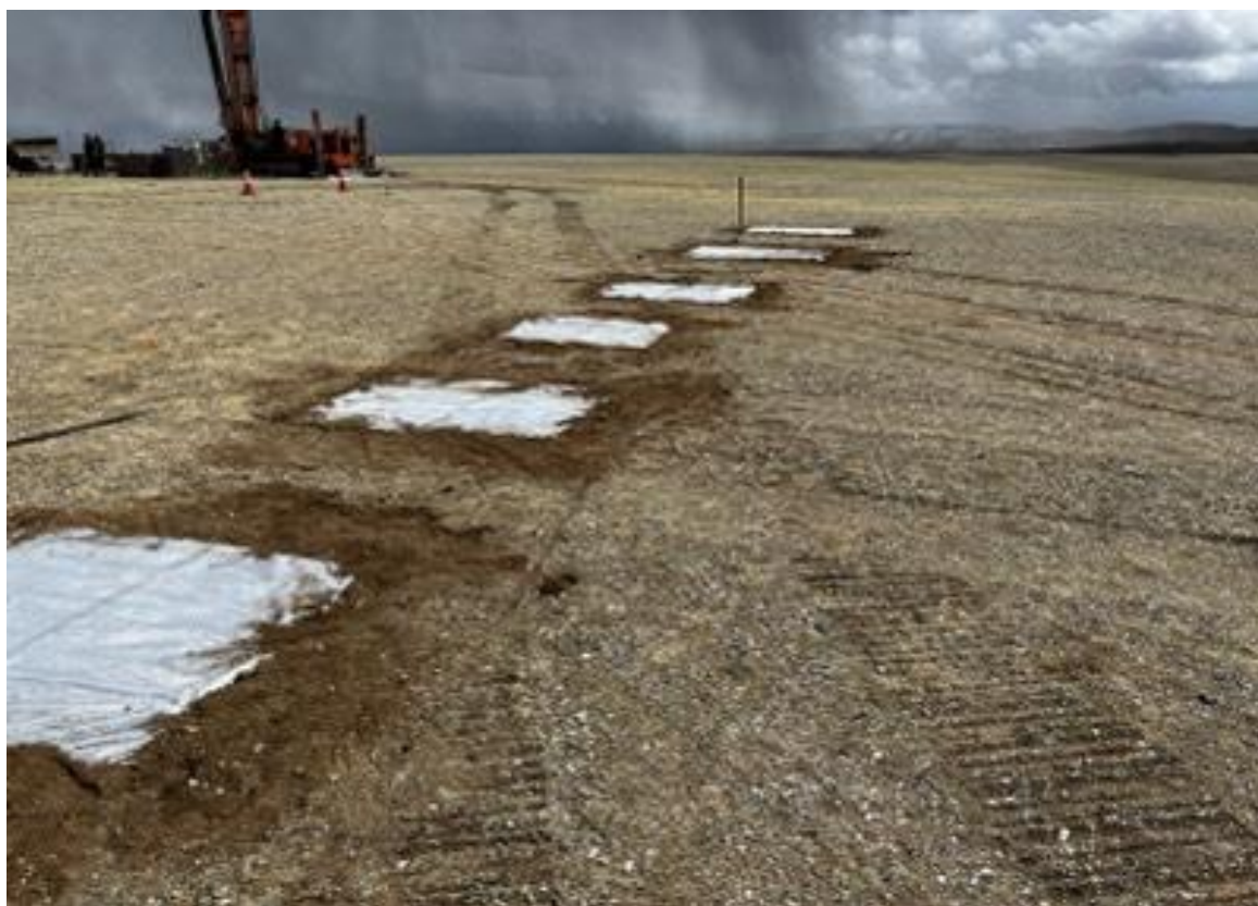
Зураг 3 Машины зогсоолын хэсэгт хөрс хамгаалах пластик уут дэвссэн байдал
