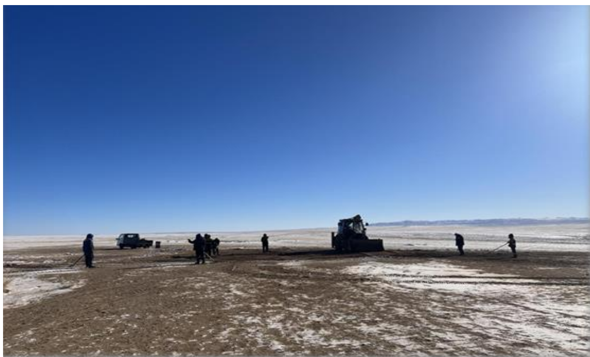
Зураг 11 Техникийн нөхөн сэргээлт хийгдэж буй байдал
