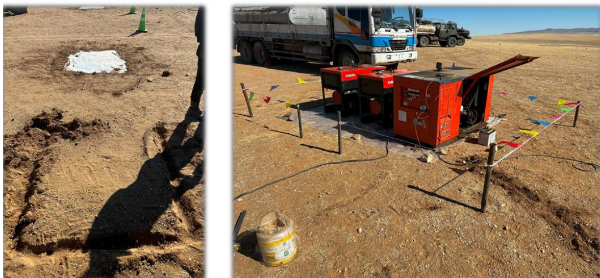
Зураг 4 Генераторын доод хэсэгт хөрс хамгаалах пластик уут дэвссэн байдал Өрөмдлөгийн ажил дууссан дараагаар, бүх пластикан дэвсгэрүүдийг авдаг.
