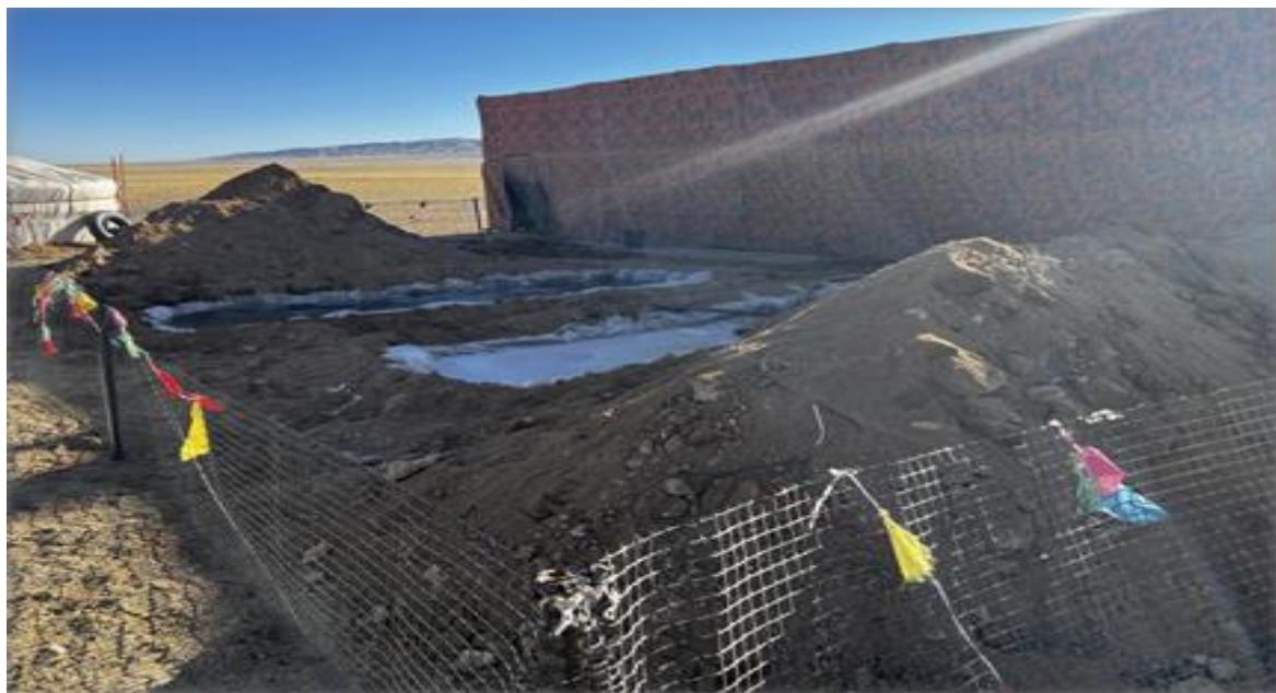
Зураг 9 Өрөмдлөгийн ажил хийж байх үйл явц
