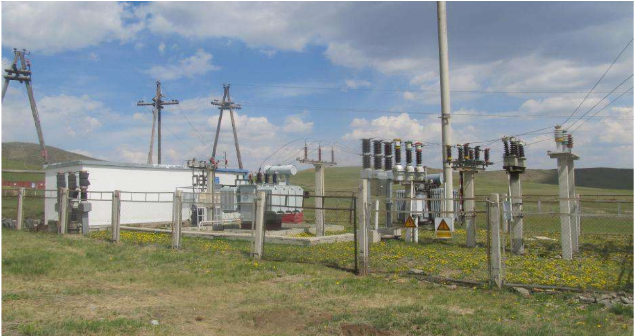
Зураг 8. Уурхайн дэд станц оролтын шугамын хүчин чадал (35000V)
