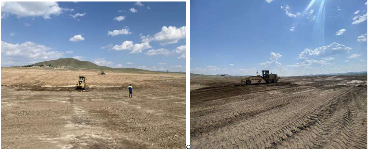
Зураг 7. Автогрейдерээр тэгшилж буй байдал
