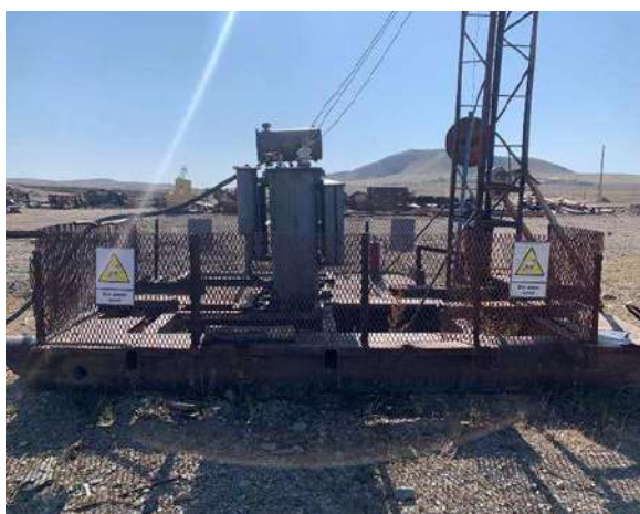
Зураг 38. Засварын талбайн өндөр хүчдэлийн трансформаторын гадна талын торон хашаанд ХАБ-ын шаардлагын дагуу АНХААРУУЛАХ ПЛАКАД -нуудыг дөрвөн талд нь байршуулж, цахилгаан хүчдэлд нэрвэгдэх эрсдэлийг бууруулж ажилласан.
