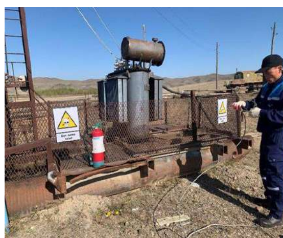
Зураг 38. Засварын талбайн өндөр хүчдэлийн трансформаторын гадна талын торон хашаанд ХАБ-ын шаардлагын дагуу АНХААРУУЛАХ ПЛАКАД -нуудыг дөрвөн талд нь байршуулж, цахилгаан хүчдэлд нэрвэгдэх эрсдэлийг бууруулж ажилласан.
