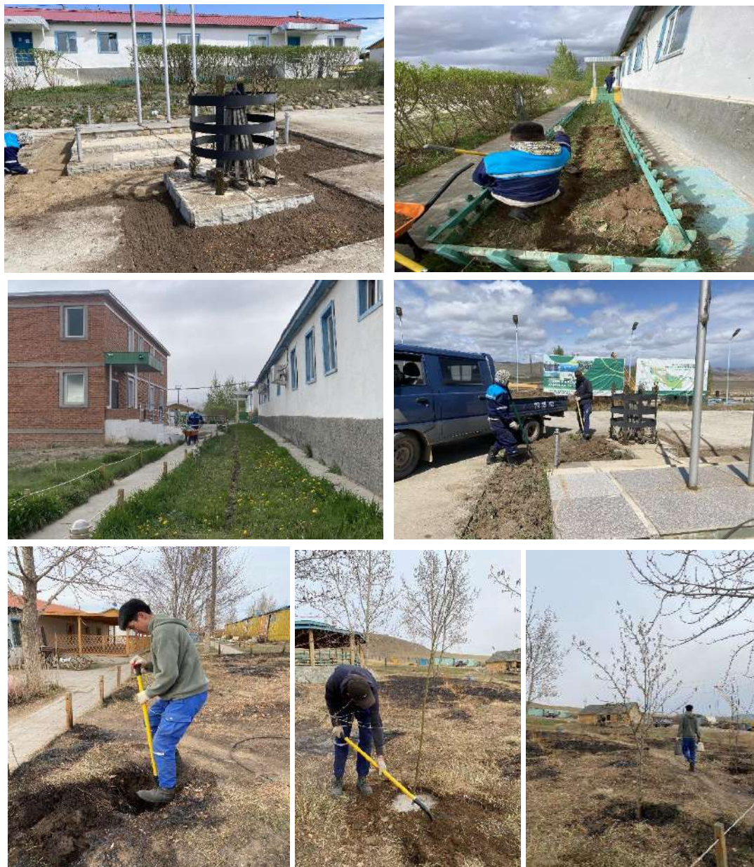
Зураг.11 Ногоон байгууламжийн ажлууд хийгдэж буй байдал
