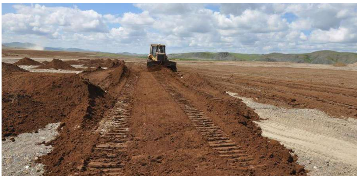
Зураг 6. Олон наст тарих талбайд дамп ковшоор шимт хөрс буулган D9R бульдозероор тарааж автогредеорээр тэгшилж буй байдал
