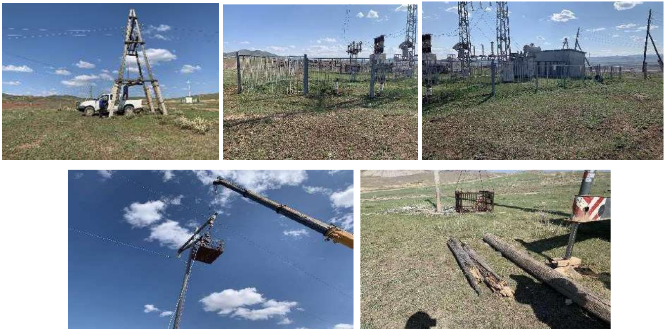
Зураг 32. Уурхайн урд, хойд 35 кВ-ын цахилгааны дэд станцуудад, төлөвлөгөөт үзлэг, засвар хийж буй байдалд хяналт тавьж, цахилгаан хүчдэлд нэрвэгдэх эрсдэлийг бууруулахад анхаарал тавьж ажилласан.
