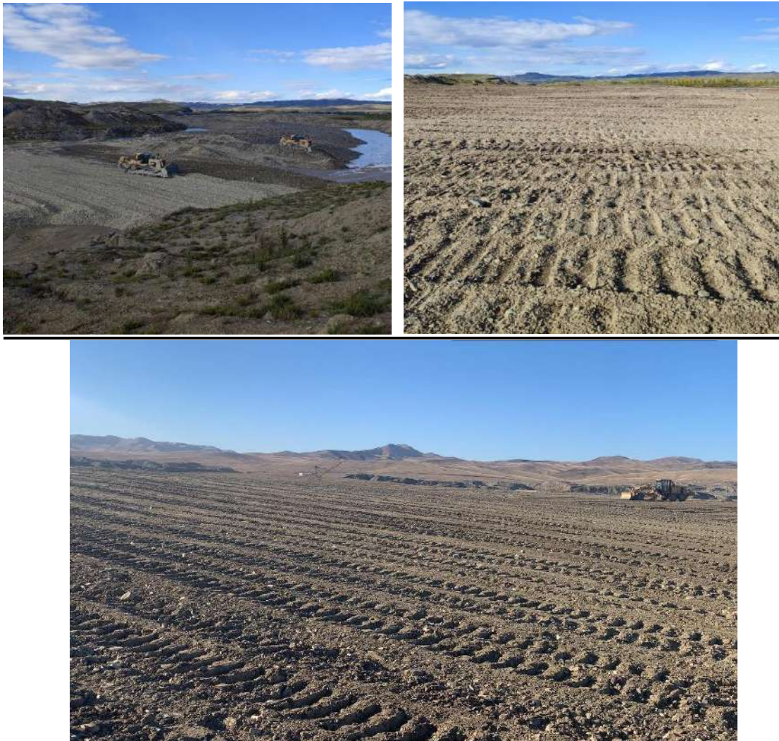
Зураг 5. Хөрс хуулалтын гадаад овоолгыг драгийн олборлолт явагдсан мөрөгцөгийн орон зайг дүүргэн Катерпиллер D9R, 2 ширхэг бульдозеруудаар тэгшилэн автогрейдерээр өнгөлгөө хийж буй байдал.
