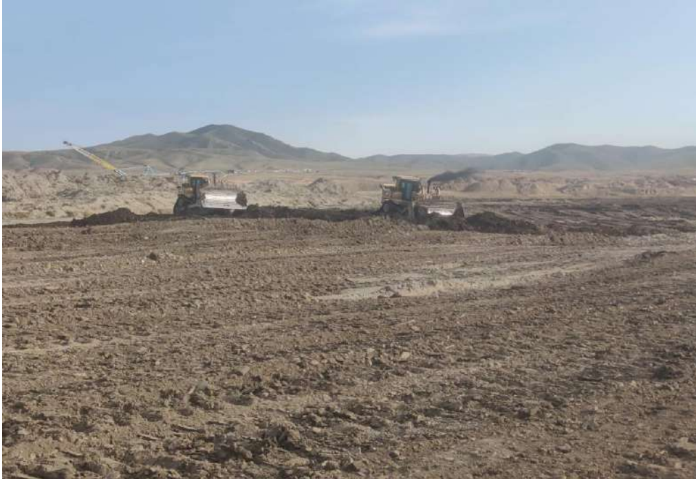
Зураг 5. Бульдозероор хэлбэржүүлэн тэгшилж автогрейдерээр өнгөлгөө хийж буй байдал
