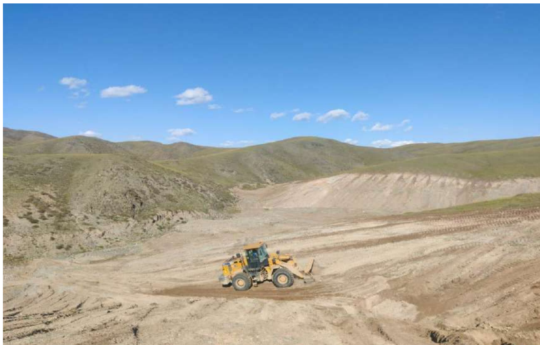
Зураг 20. Дүйцүүлэн ажил хийгдэхээс өмнөх байдал
