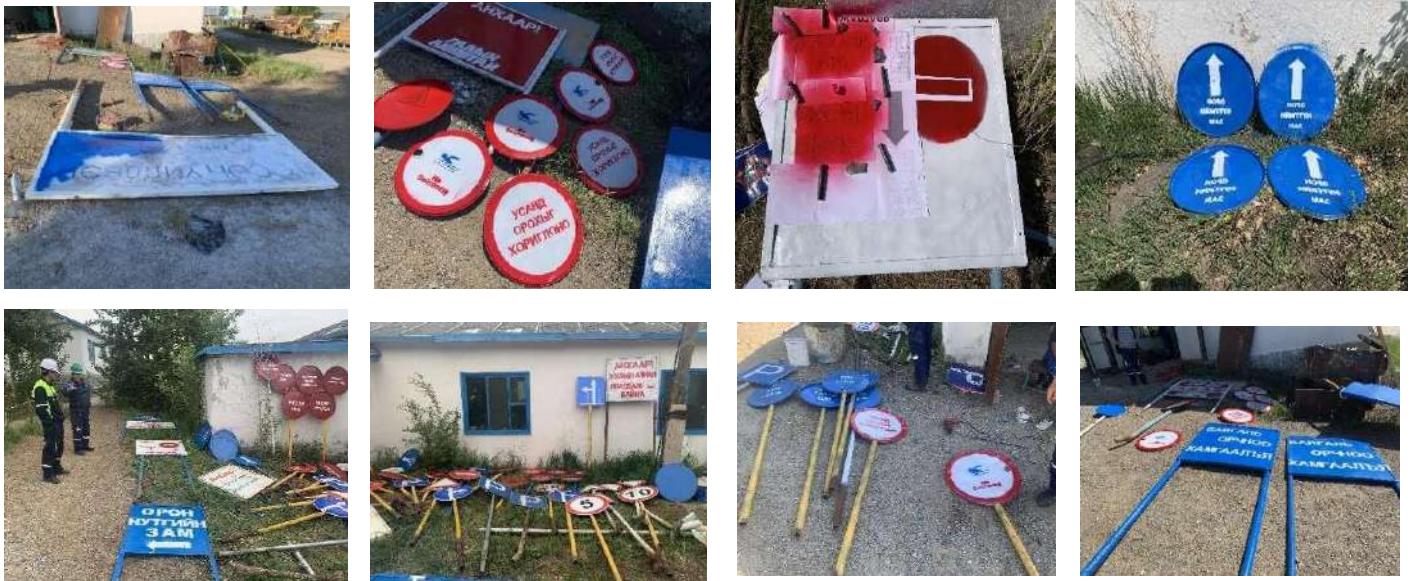
Зураг 28. Хуучирч, элэгдсэн, будаг нь бүдгэрсэн, эвдэрч хаягдсан тэмдэг тэмдэглэгээнүүдийг цуглуулж, засварлаж, шинэчлэн будаж, шаардлагатай байгаа тэмдэг болгон цоолборложбудсан, байрлуулахад бэлэн болсон тэмдэгнүүдийн байдал.
