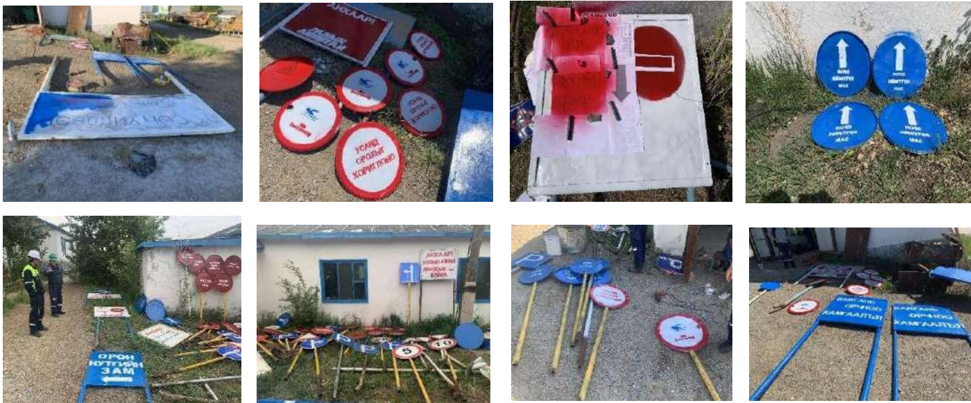
Зураг 30. Хуучирч, элэгдсэн, будаг нь бүдгэрсэн, эвдэрч хаягдсан тэмдэг тэмдэглэгээнүүдийг цуглуулж, засварлаж, шинэчлэн будаж, шаардлагатай байгаа тэмдэг болгон цоолборложбудсан, байрлуулахад бэлэн болсон тэмдэгнүүдийн байдал.
