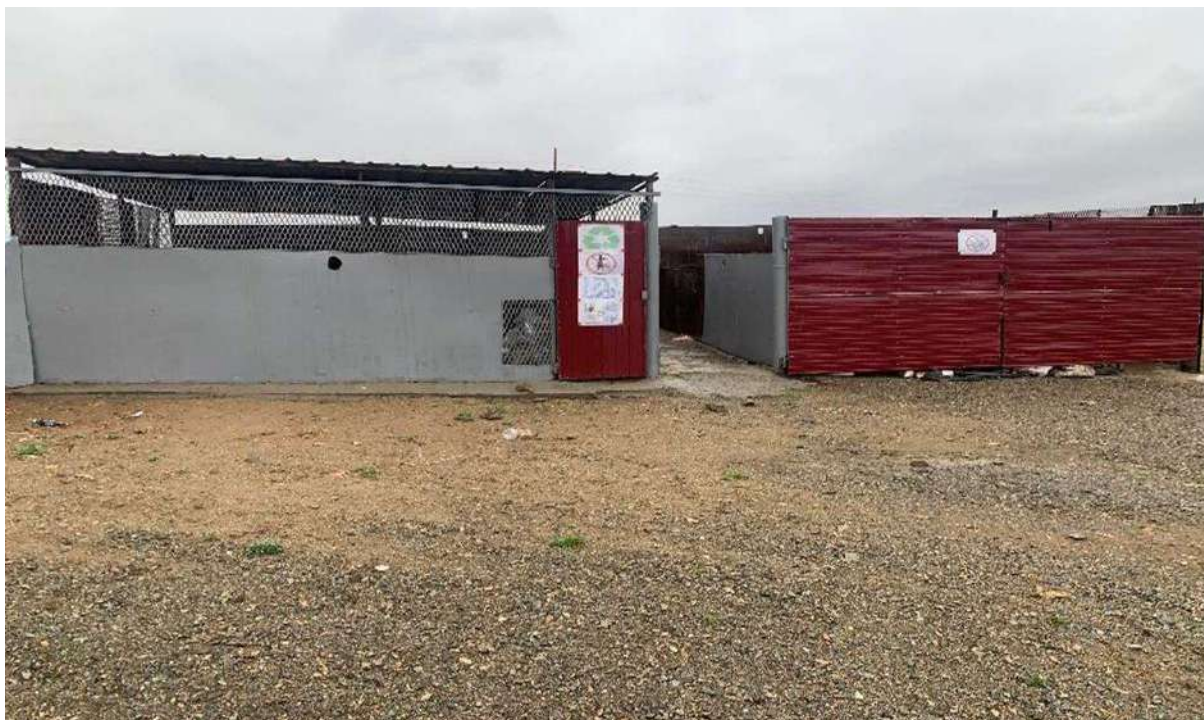
Зураг 45. Хогийн цэгийг шинэчлэн сайжруулсан байдал
