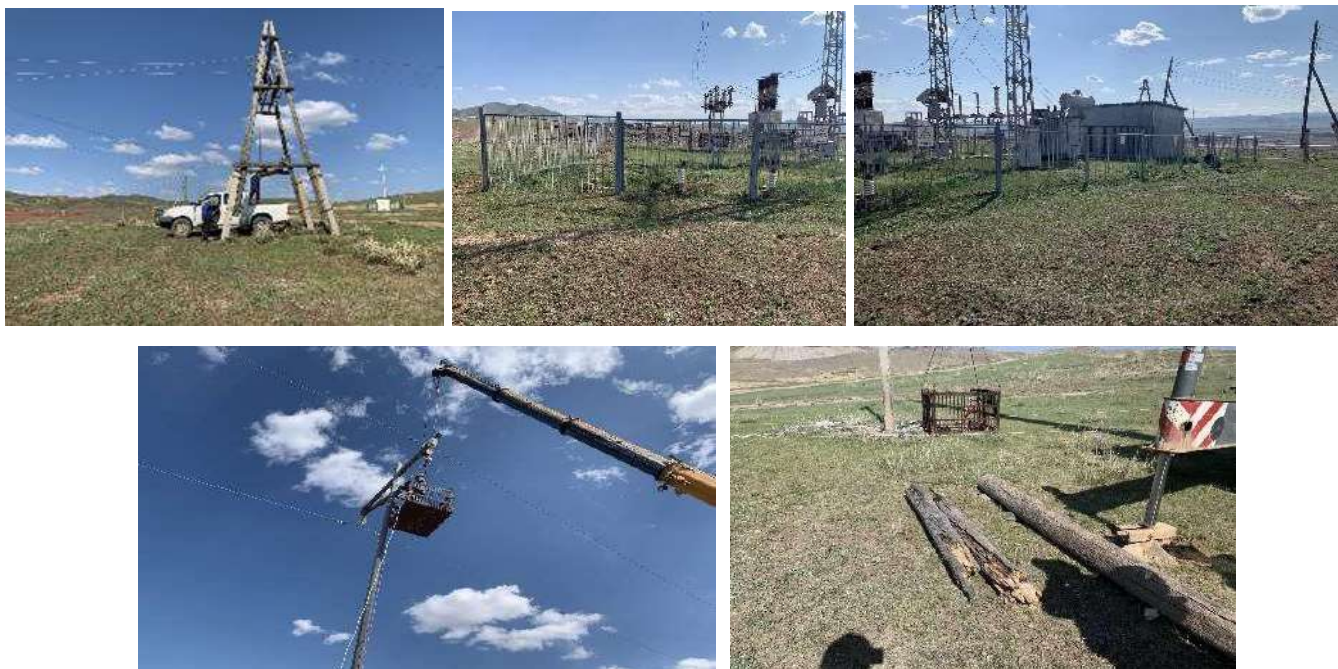
Зураг 27. Уурхайн урд, хойд 35 кВ-ын цахилгааны дэд станцуудад, төлөвлөгөөт үзлэг, засвар хийж буй байдалд хяналт тавьж, цахилгаан хүчдэлд нэрвэгдэх эрсдэлийг бууруулахад анхаарал тавьж ажилласан.
