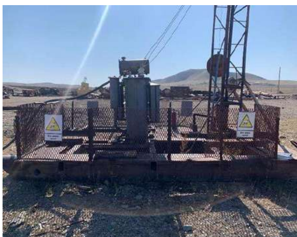
Зураг 33. Засварын талбайн өндөр хүчдэлийн трансформаторын гадна талын торон хашаанд ХАБ-ын шаардлагын дагуу АНХААРУУЛАХ ПЛАКАД -нуудыг дөрвөн талд нь байршуулж, цахилгаан хүчдэлд нэрвэгдэх эрсдэлийг бууруулж ажилласан.
