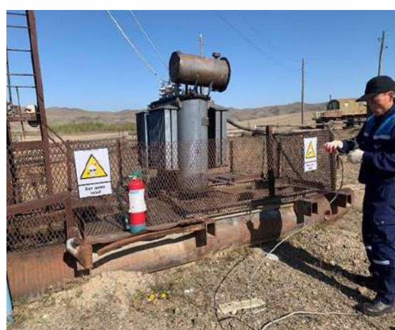
Зураг 33. Засварын талбайн өндөр хүчдэлийн трансформаторын гадна талын торон хашаанд ХАБ-ын шаардлагын дагуу АНХААРУУЛАХ ПЛАКАД -нуудыг дөрвөн талд нь байршуулж, цахилгаан хүчдэлд нэрвэгдэх эрсдэлийг бууруулж ажилласан.
