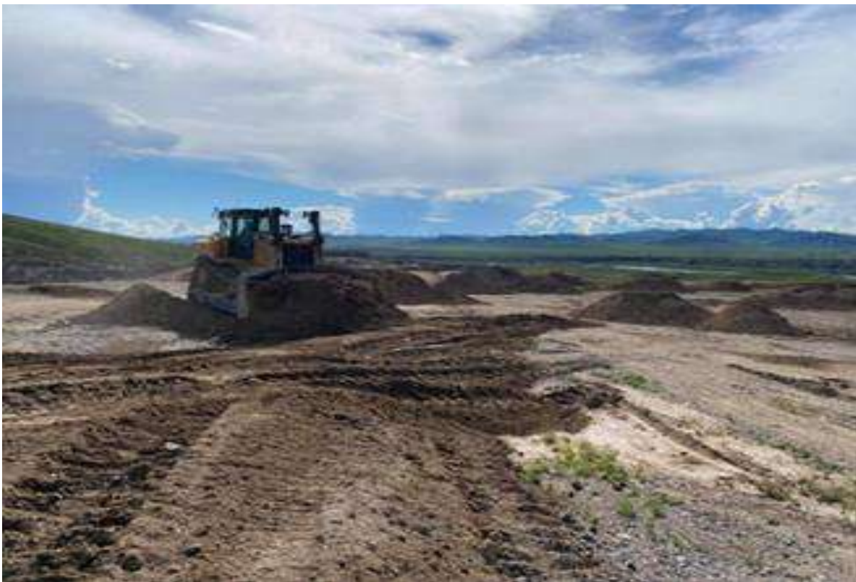
Зураг 6. Дамп ковшоор шимт хөрс буулган D9R бульдозероор тарааж буй байдал
