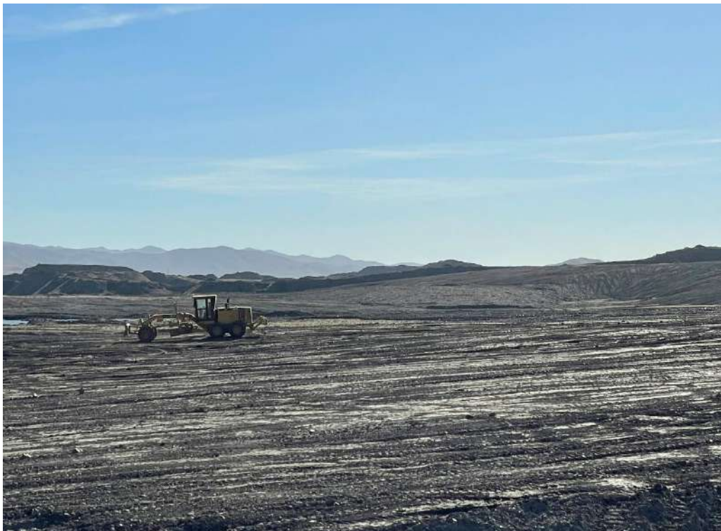
Зураг 5. Бульдозероор хэлбэржүүлэн тэгшилж автогрейдерээр өнгөлгөө хийж буй байдал
