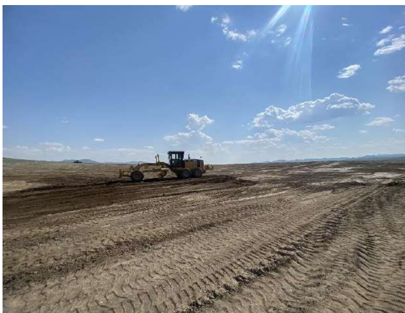
Зураг 6. Олон наст тарих талбайд дамн ковшоор шимт хөрс буулган D9R бульдозероор тарааж автогредеорээр тэгшилж буй байдал
