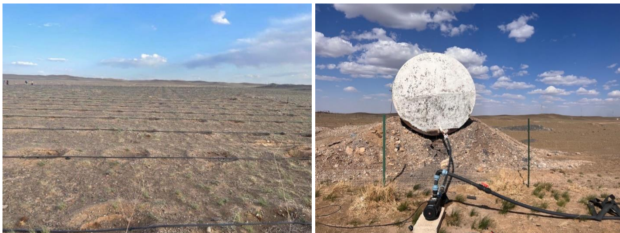
Зураг 5.2.1 Ажилчдын хотхоны гадна талбайн ногоон байгууламжийн усалгааны систем
