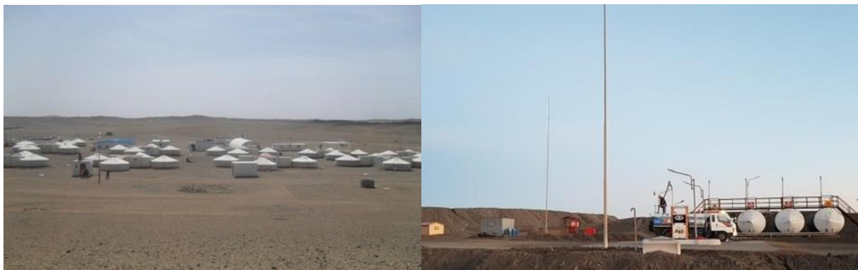
Зураг 1.2. Уурхайн тосгон ба шатахуун түгээх станц
