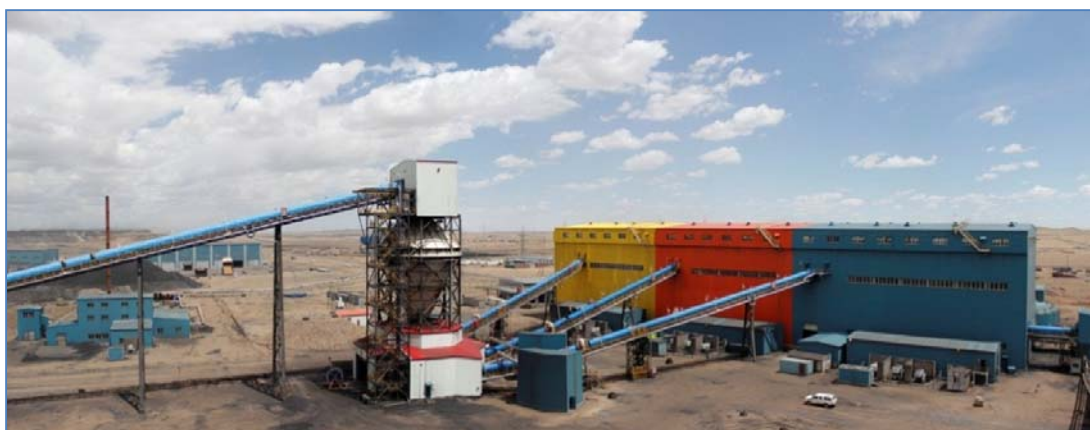
Зураг 1.2. Нүүрс баяжуулах үйлдвэр
