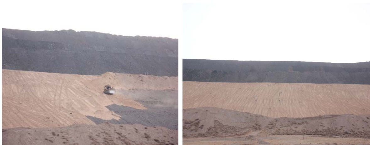
Зураг 5.2.1. Хаягдлын овоолгын хэлбэршүүлсэн талбай дээр шимт хөрсийн хучилт хийж буй байдал
