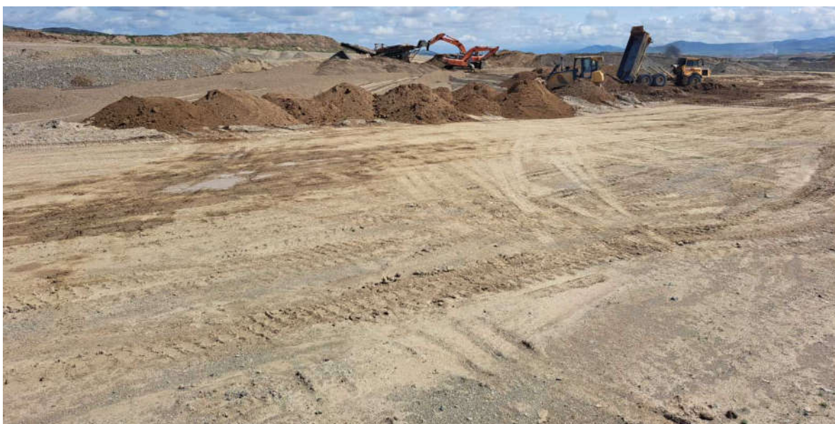
Зураг. Хаягдлын санг нөхөн сэргээж буй байдал
