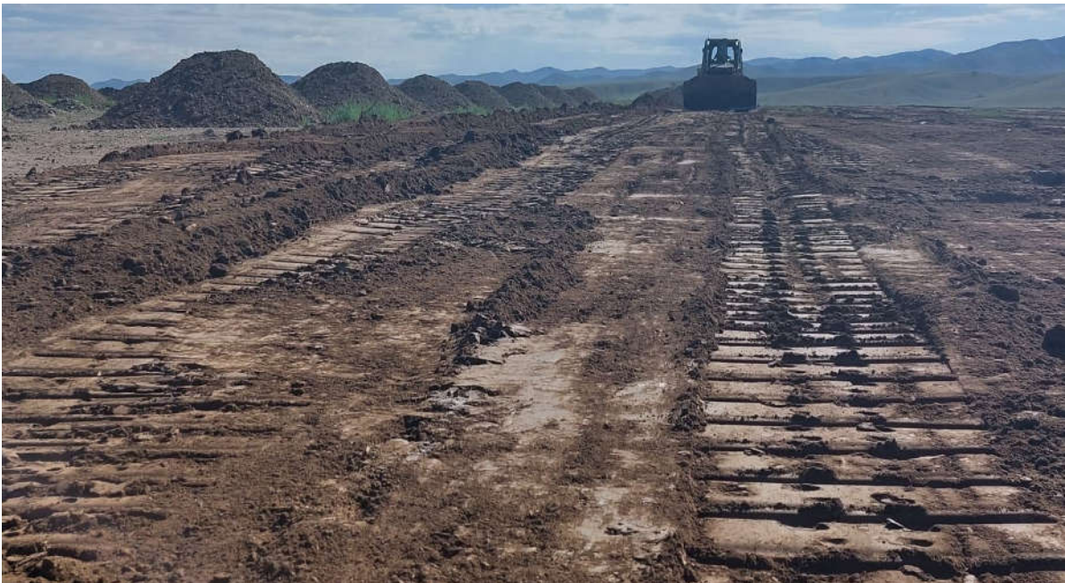
Зураг. Шимт хөрсөөр хучилт хийж буй байдал
