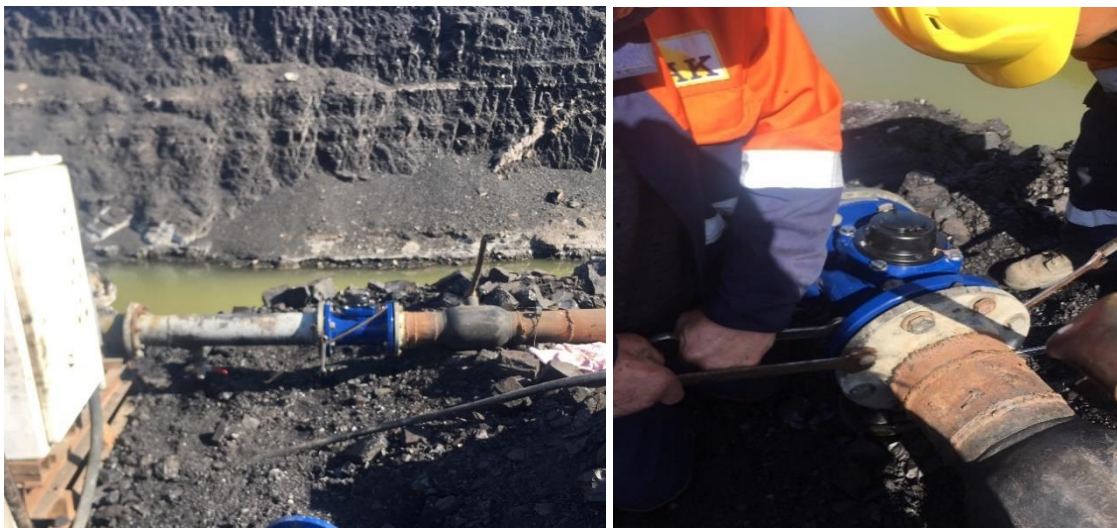
Зураг 4. Шүүрлийн усны насос тоолуур суурьлуулж байгаа нь
