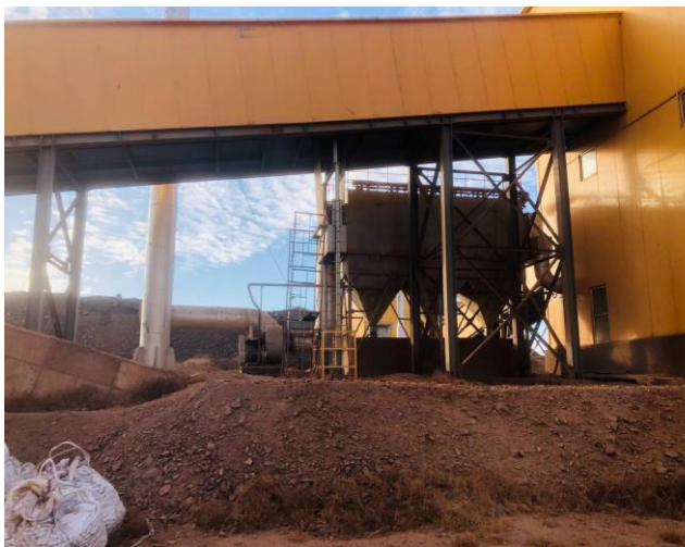
Зураг 11. Баяжуулах үйлдвэрийн тоосжилт их гарах хэсгүүдэд суурилуулсан вентилятор
