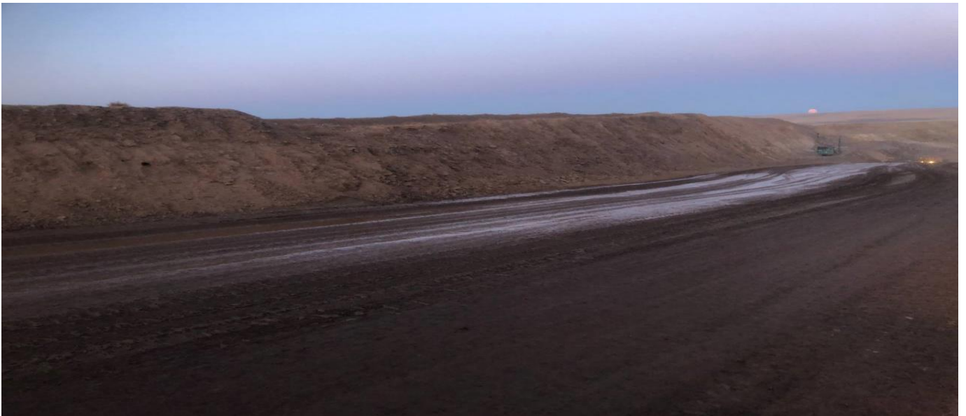
Зураг 7. Уурхайн зам талбайн тоосжилтыг дарах усалгаа хийсэн
