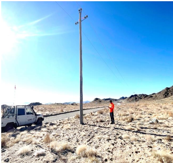
Цахилгааны шонгийн шувуу үргээх хэрэгсэлийн бүрэн бүтэнд байдал хяналт тавьж буй байдал
