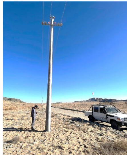
Цахилгааны шонгийн шувуу үргээх хэрэгсэлийн бүрэн бүтэнд байдал хяналт тавьж буй байдал
