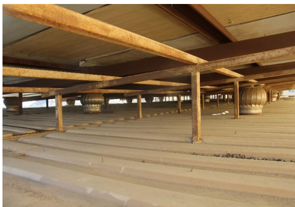
Агуулахын механик вентилятор
