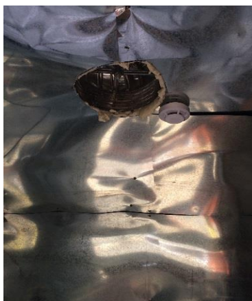
Агуулахад механик вентилятор болон утаа мэдрэгч байршуулсан байдаг
