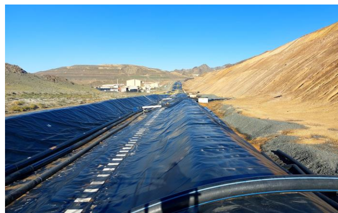
НУТ-н үерийн далан болон уусмал цуглуулах хайрцаг, уусмал дамжуулах хоолойн бүрэн бүтэн байдалд өдөр тутмын хяналтын зургаас
