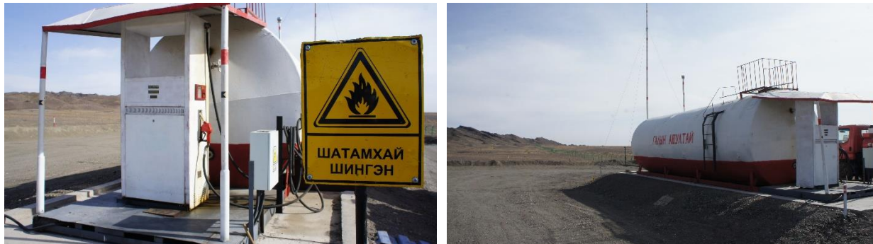
Зураг 5. Шатахуун түгээх станцын байгууламж
