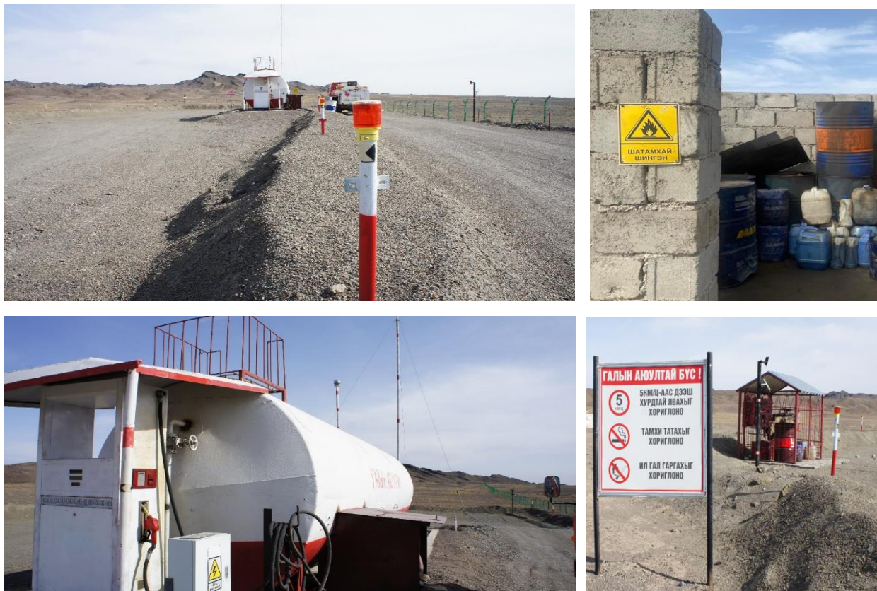
Зураг 9. Шатахуун түгээх станц
