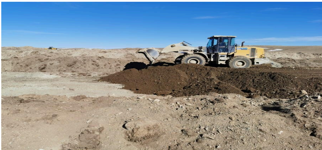
Уурхайн техникийн нөхөн сэргээлтээр дүүргэлт хийсний дараах тэгшилж буй үеийн зураг
