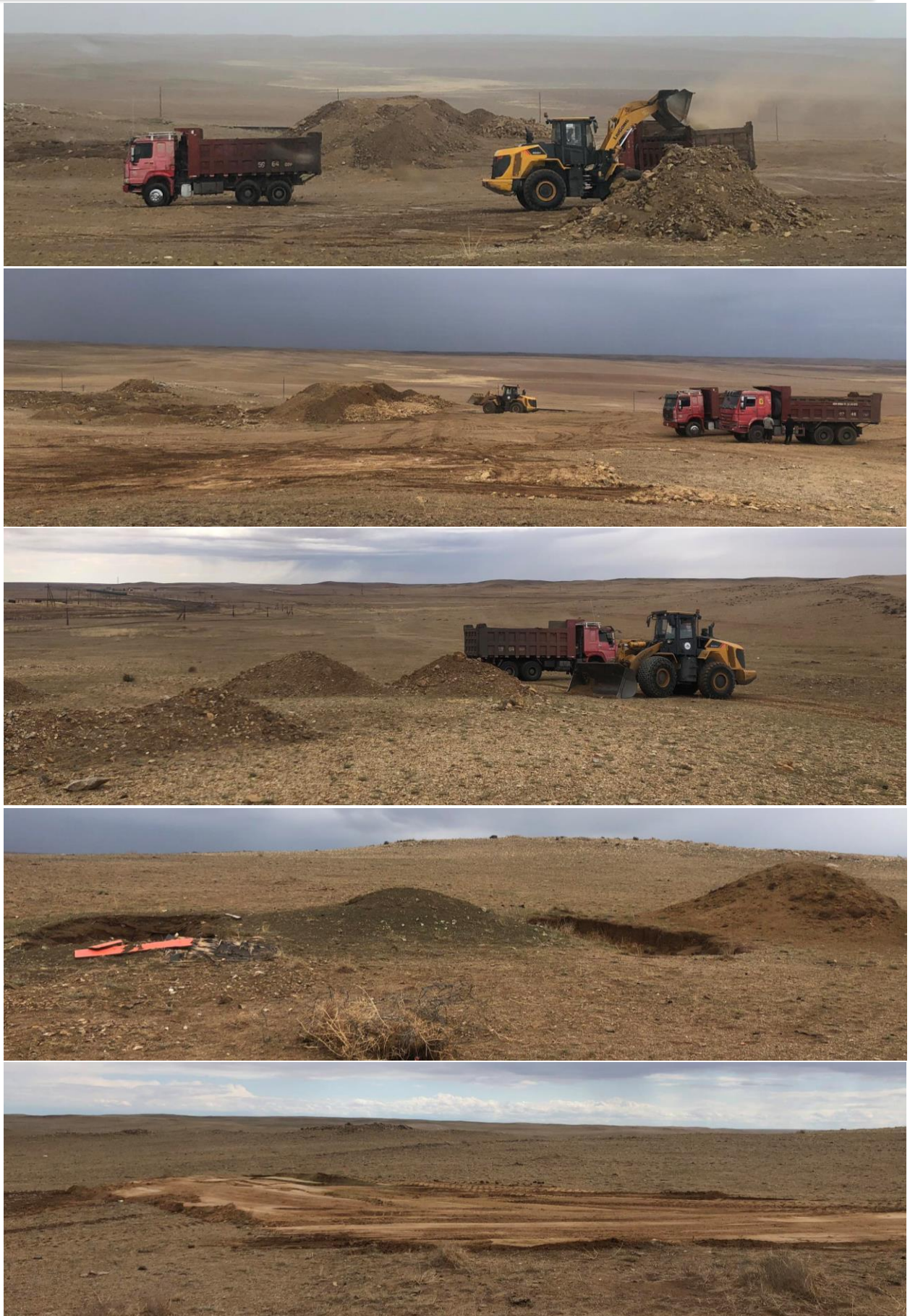
Зураг 39. Жижиг ухашыг нөхөн дүүргэлт хийх, жижиг асгаас хөрсийг зөөж тээвэрлэн тэгшилж байгаа болон нөхөн сэргээлтийн ажлын дараа
