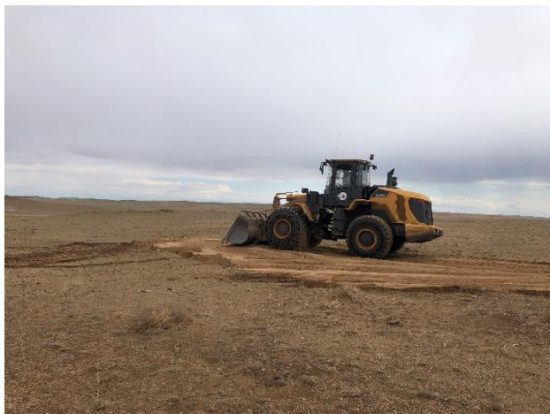
Зураг №16-6 Жижиг ухашуудыг нөхөн дүүргэлт хийж тэгшилж байгаа болон нөхөн сэргээлтийн ажлын дараа
