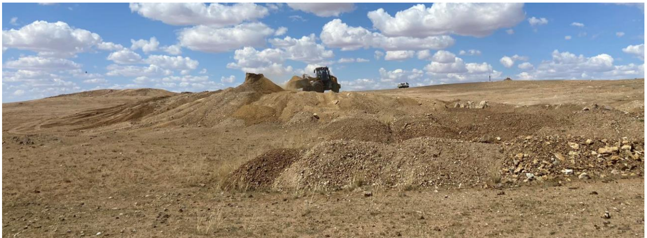
Зураг 37. Томоохон овоолгыг налуулж хэлбэршүүлж байгаа болон нөхөн сэргээлтийн ажлын дараа
