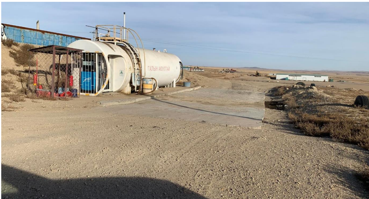
Зураг 13. ШТС-ын талбайг цементэн хучилттай болгосон байдал
