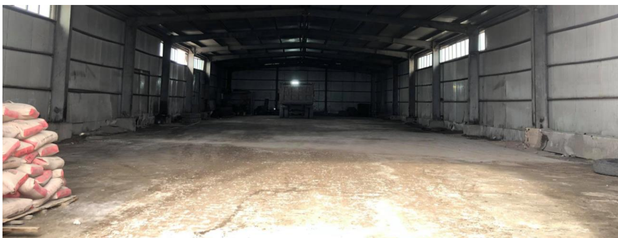
Зураг 17. Грашийн шалыг цементжүүлсэн байдал /2021 онд /
