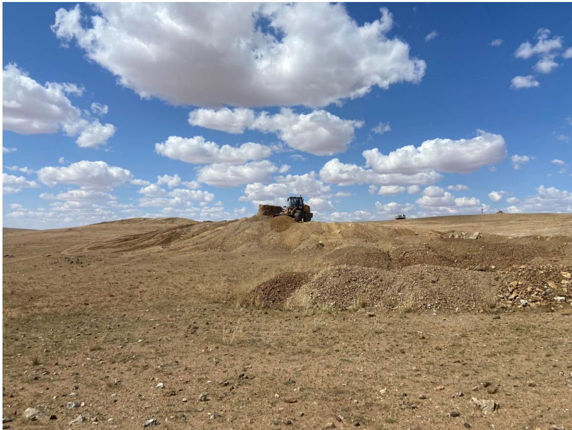
Зураг №16-3 Томоохон асгаасыг түрж тэгшилж байгаа болон нөхөн сэргээлтийн ажлын дараа
