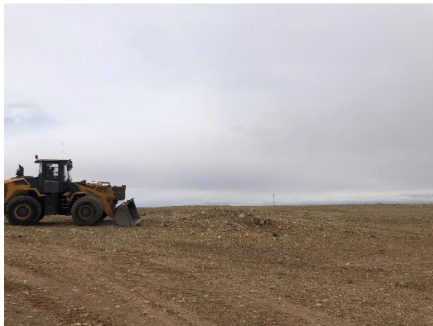
Зураг №16-6 Жижиг ухашуудыг нөхөн дүүргэлт хийж тэгшилж байгаа болон нөхөн сэргээлтийн ажлын дараа
