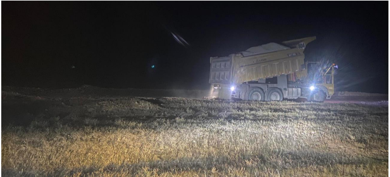
Зураг 8. Гадна тээврийн зам засах ажилд автосамосвал гаргаж ажил гүйцэтгэсэн байдал /2023.09.15/
