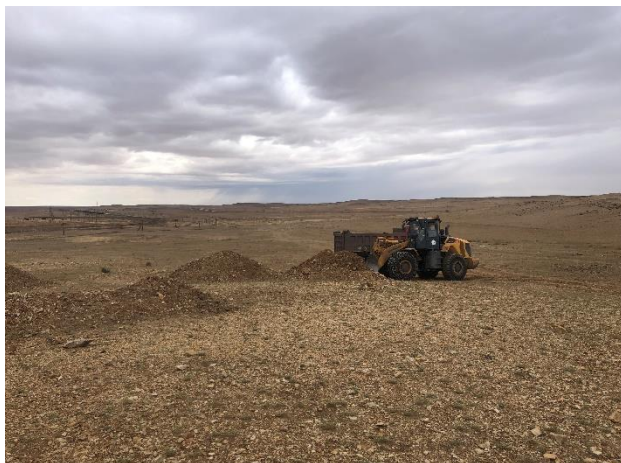
Зураг №16-7 Жижиг асгаасуудыг ачиж зоож буулган түрж тэгшилж байгаа болон нөхөн сэргээлтийн ажлын дараа
