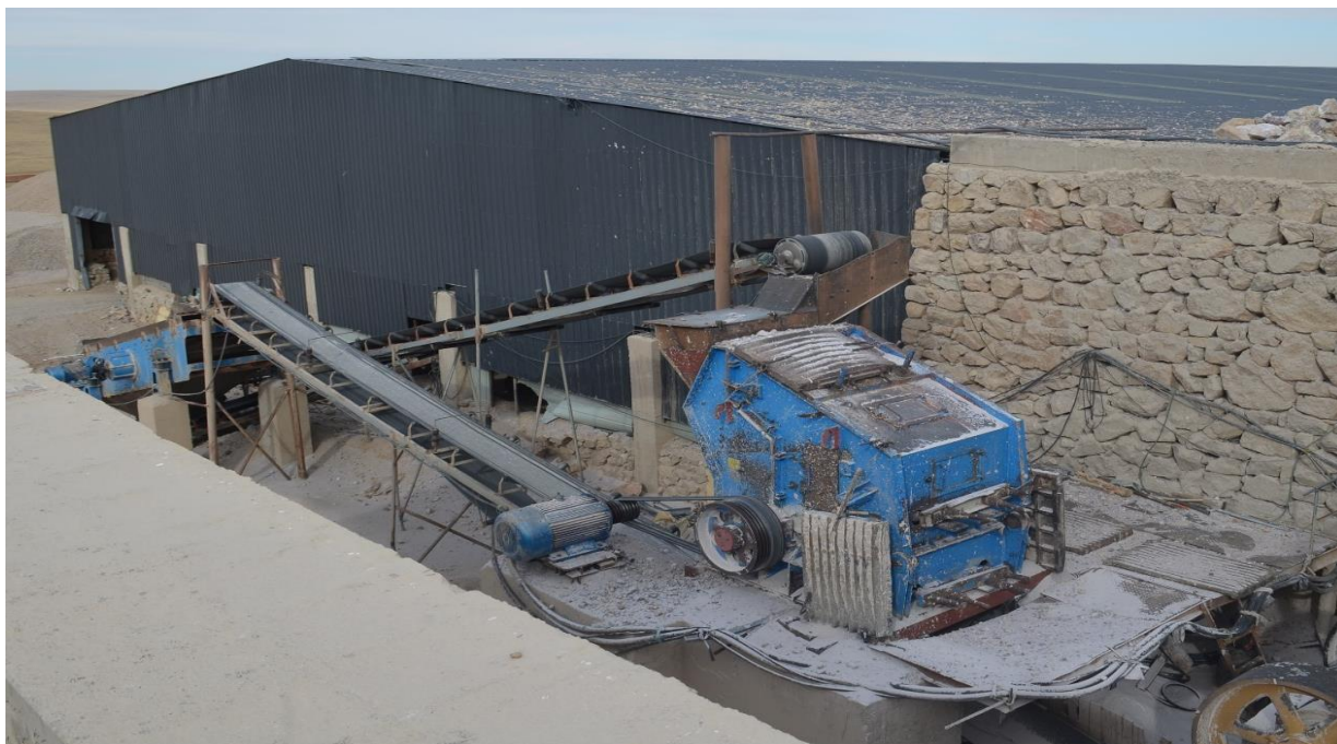
Зураг 2. Баяжуулах үйлдвэрийн хүдэр бутлах хэсгийн фото зураг
