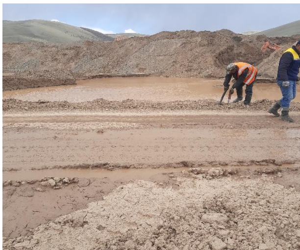
Зураг № 6. Зам арчилгаа хийсэн буй байдал
