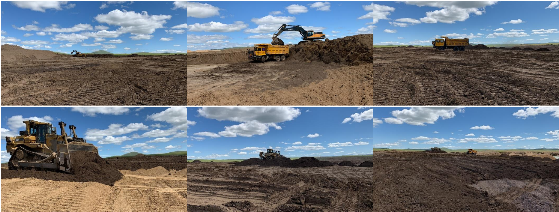
Зураг 18. Нөхөн сэргээлтийн менежментийн төлөвлөгөөний 2 дугаар заалтын биелэлтийн нэмэлт ажлыг зураглал-1 /Шимт хөрсийг түрэлт хийж тэгшилсэн талбайд шимт хөрсөөр хучиж тэгшилж буй зураглал/
