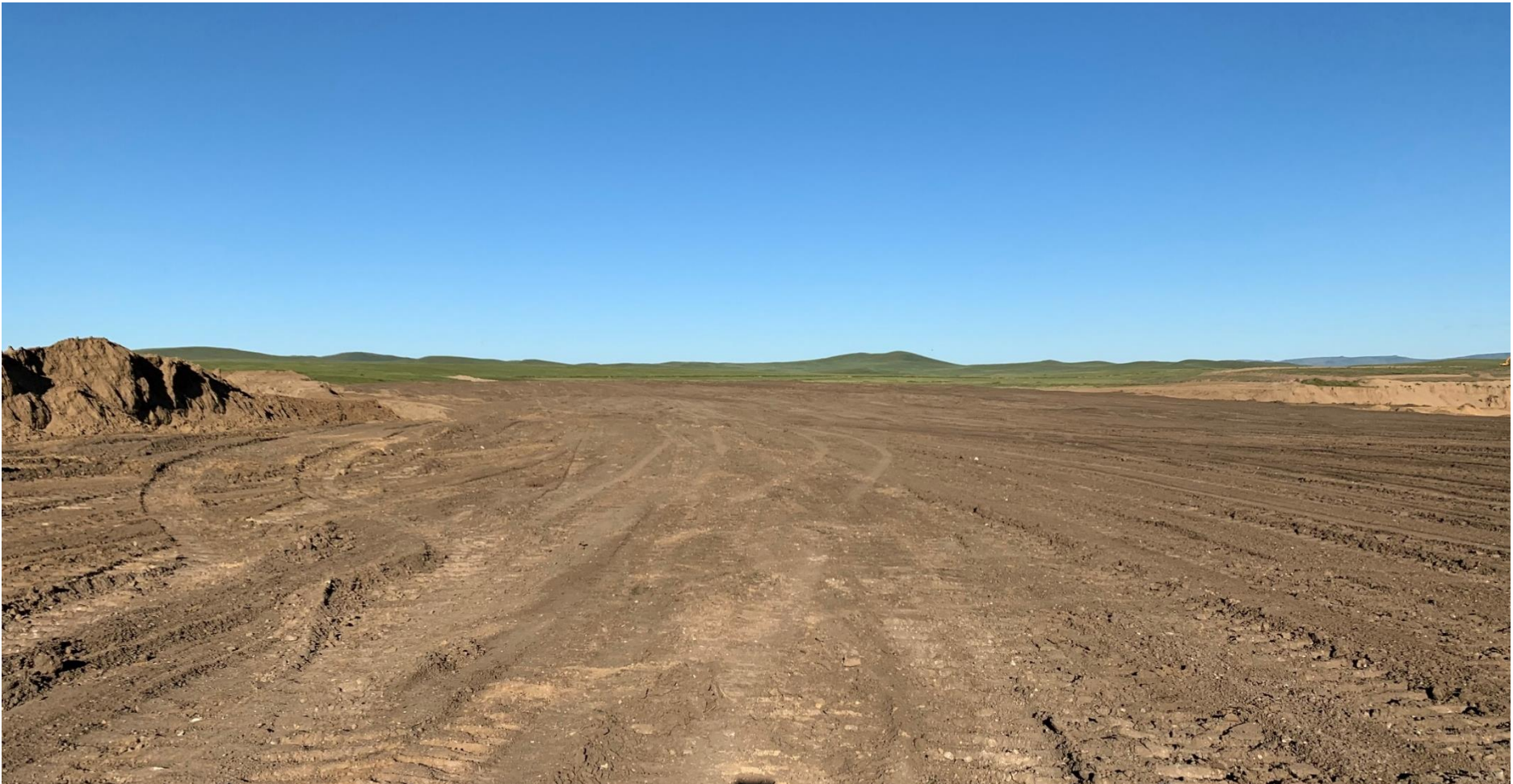
Зураг 19. Нөхөн сэргээлтийн менежментийн төлөвлөгөөний 2 дугаар заалтын биелэлтийн нэмэлт ажлыг зураглал-2 /Шимт хөрсийг түрэлт хийж тэгшилсэн талбайд шимт хөрсөөр хучиж тэгшилж буй зураглал/
