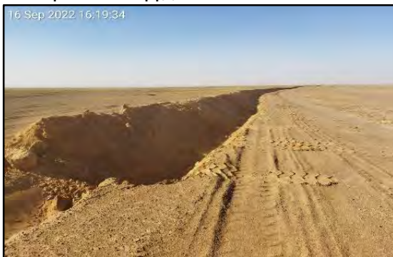
Зураг № 34. Замын хөмсөгжүүлэлт, засварын ажил гүйцэтгэж буй байдал
