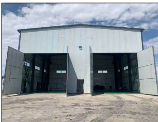
Зураг № 110. Засварын төвийн гадна талбайг бетондсон байдал
