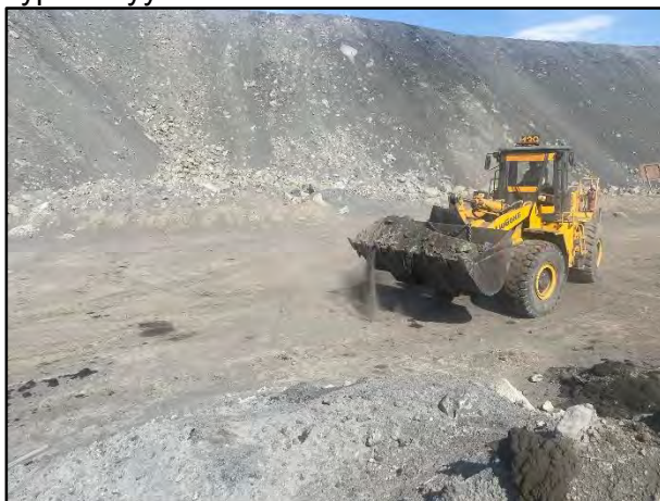
Зураг № 31. Бохирдсон хөрсийг Remediator бодис ашиглан саармагжуулж буй байдал
