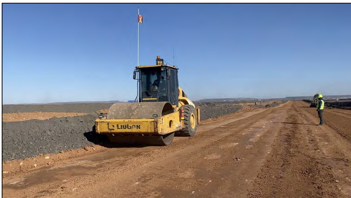
Зураг № 15. Гадаргуугын өнгөлгөө хийж буй байдал
