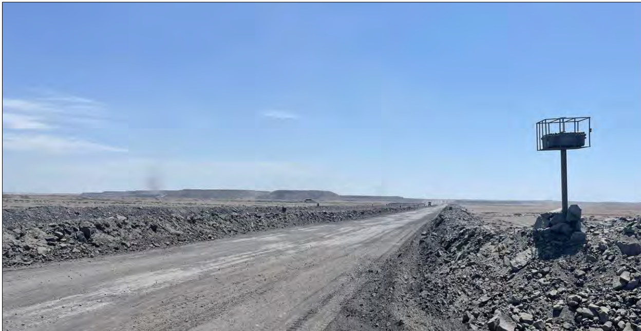
Зураг № 3. Туршилт хийхээр сонгон авсан замд тоосны хэмжилт хийж буй байдал
