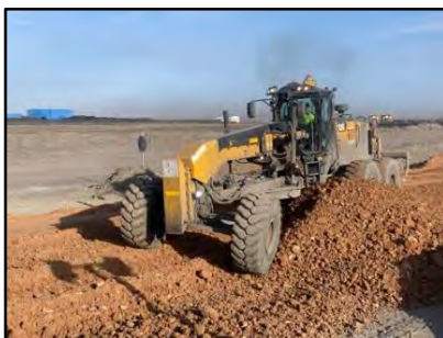
Зураг № 12. Технологийн замд дэвсэлт хийж буй байдал
