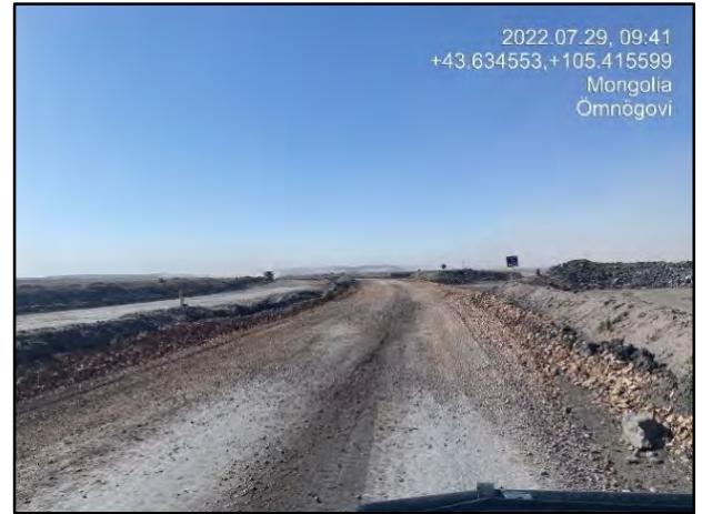
Зураг № 17. Технологийн зам уулзваруудад улаан шавран материал дэвсэж буй байдал
