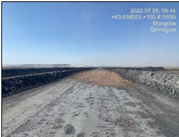
Зураг № 17. Технологийн зам уулзваруудад улаан шавран материал дэвсэж буй байдал
