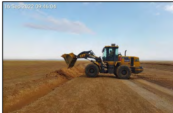
Зураг № 34. Замын хөмсөгжүүлэлт, засварын ажил гүйцэтгэж буй байдал
