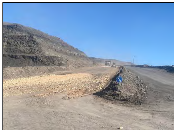
Зураг № 20. Уурхайн технологийн замын уулзваруудад дэвсэлт хийсэн байдал
