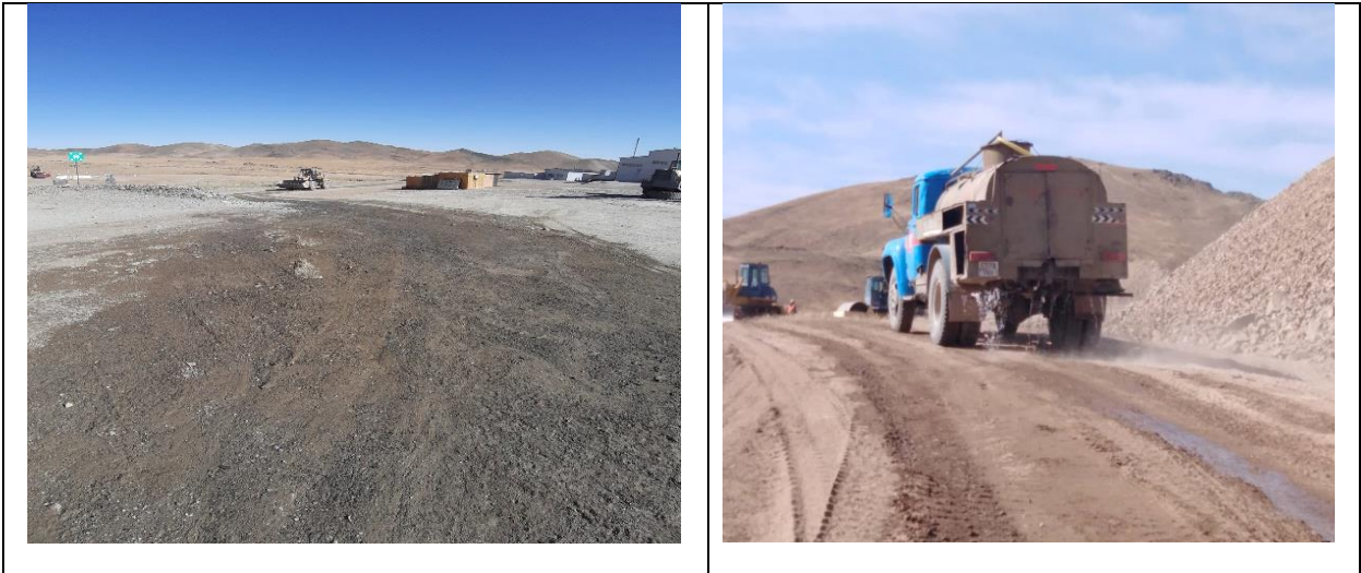
Зураг 21. Замын тоосжилт дарах усалгаа хийж буй байдал
