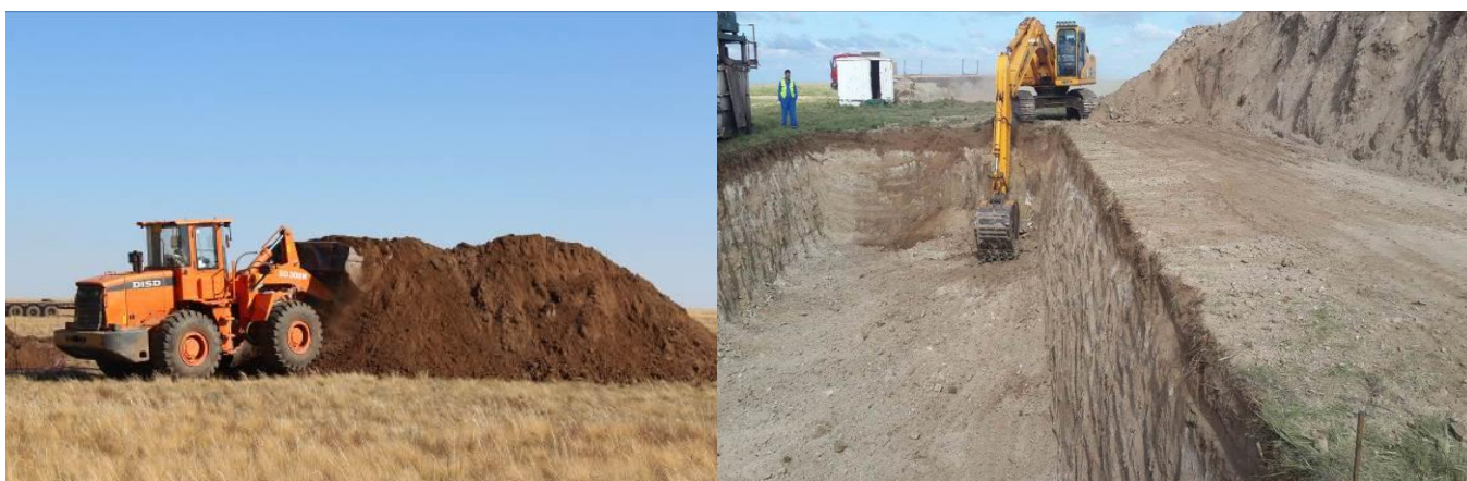
Зураг № 17. Өрмийн шаврын хаягдлын сан байгуулж буй байдал
