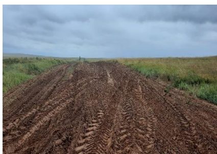
Зураг № 20. Ашиглагдахгүй болсон замыг хагалж сийрүүлж, буталж байгаа байдал
