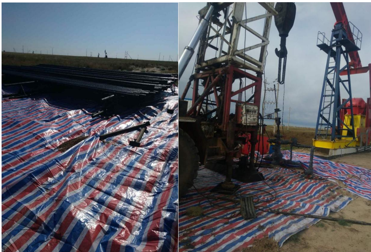
Зураг-1. Ажил эхлэхээс өмнө хөрсөнд тос нэвчхээс хамгаалан дэвсгэр дэвсэж буй байдал
