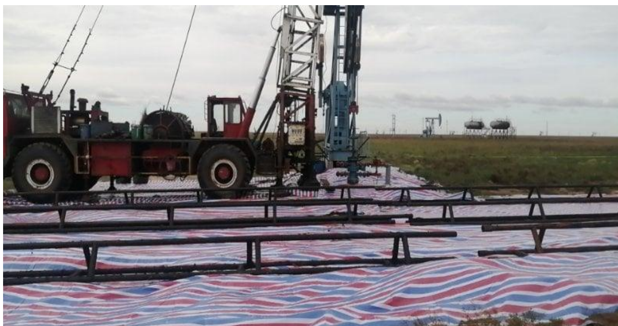
Зураг-2. Ажил эхлэхээс өмнө хөрсөнд тос нэвчхээс хамгаалан дэвсгэр дэвсэж буй байдал
