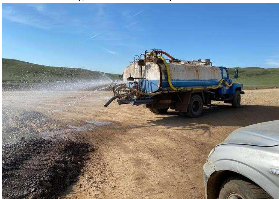
Зураг №11. Усалгаа хийж буй байдал
