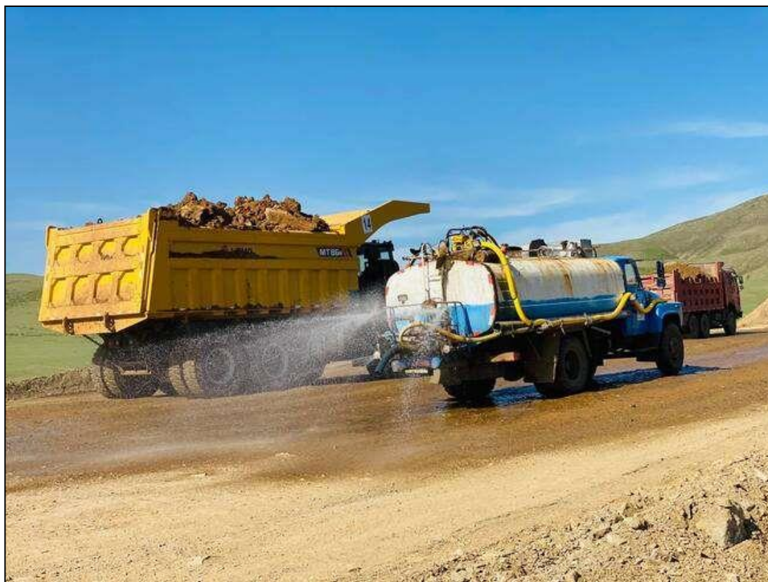
Зураг №10. Усалгаа хийж буй байдал
