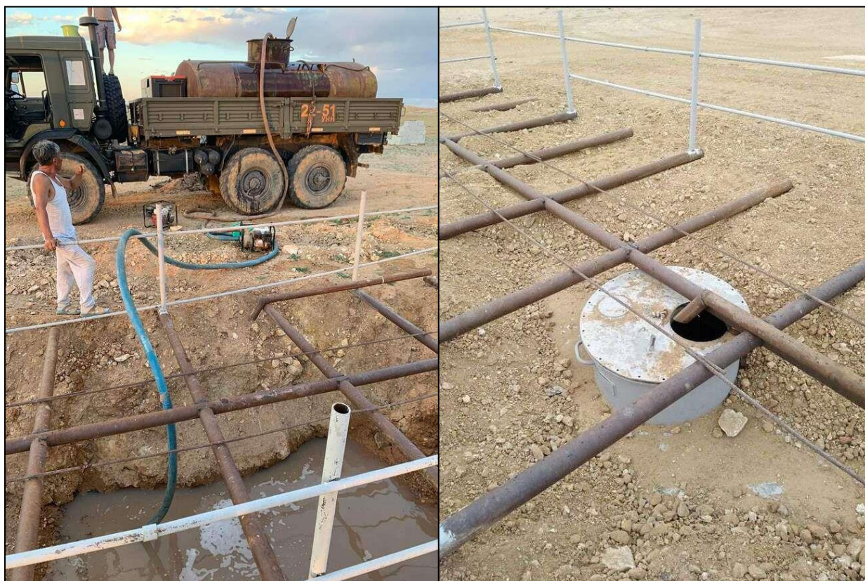
Зураг №8. Зам талбайн усалгаа хийж буй байдал
