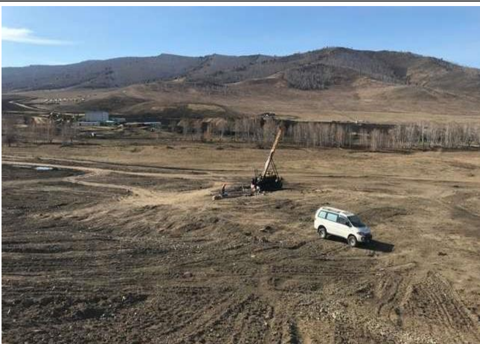
Зураг №5. В-1 блокийн Техникийн нөхөн сэргээлт дуусаж, шимт хөрсөөр хучсан байдал
