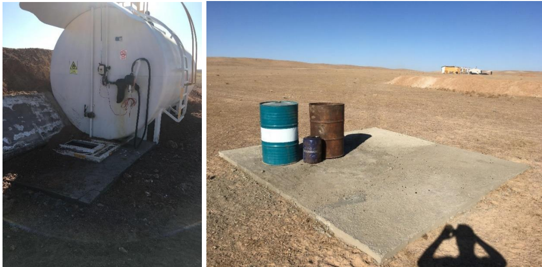
Зураг 6. Хөрс хамгаалах зорилгоор бетондсон талбай
