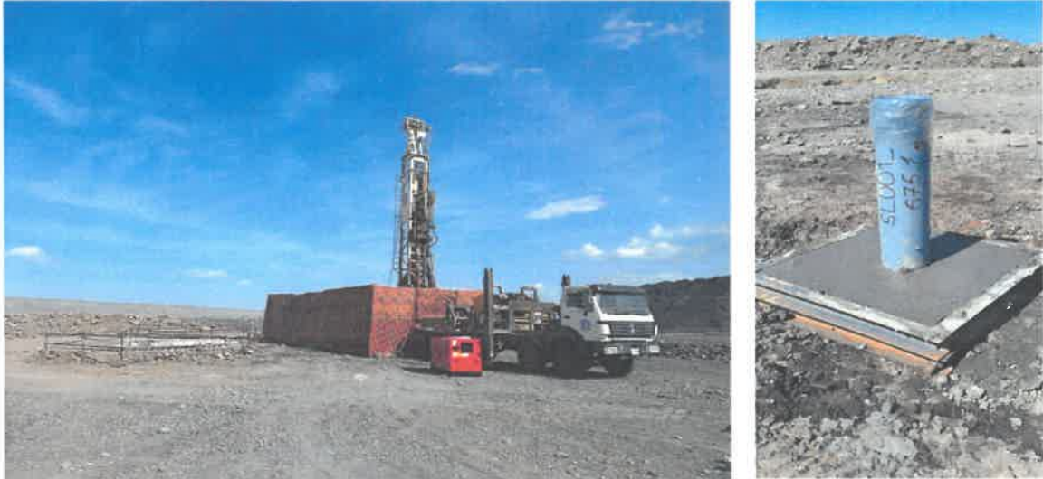
Зураг 4. SL_001 цооногийн өрөмдлөгийн эхэн үед, цооног хаасан байдал
