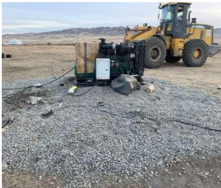
Тос тослох материал хөрсөнд нэвчихээс сэргийлж хайрга дэвсүүлсэн
