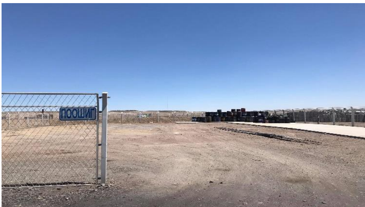
Зураг 67. Хаягдал поошиг хураах талбайг бетондсон байдал
