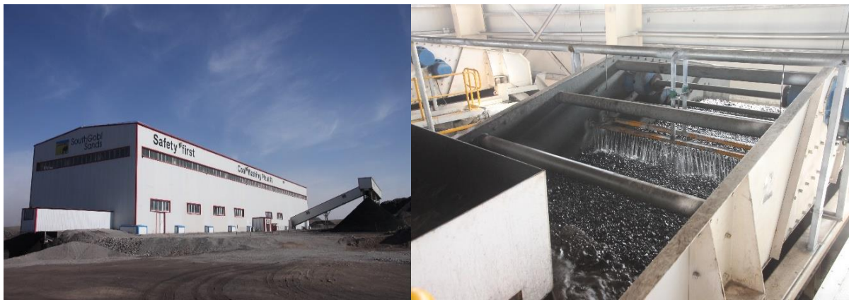
Зураг 104. Нүүрсийг нойтон технологиор баяжуулах үйлдвэр
