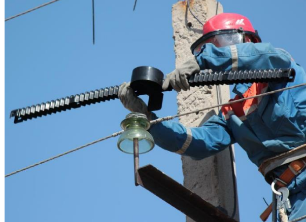
Зураг 0.48 Пластик хамгаалалтын бүрхүүл шувуу үхэх эрсдэлийг бууруулна. А.В. Салтыков, Г.С. Джамирзоев Руководство по обеспечению орнитологической безопасности электросетевых объектов средней мощности (методическое пособие), 2015 года
