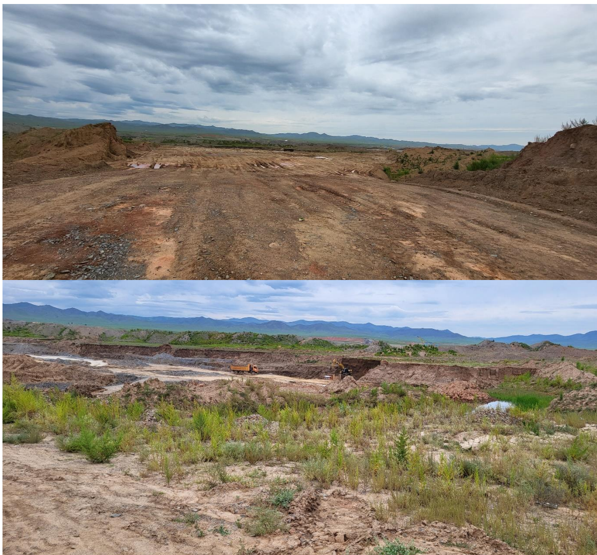
Зураг 2.Нөхөн сэргээлт хийж буй байдал
