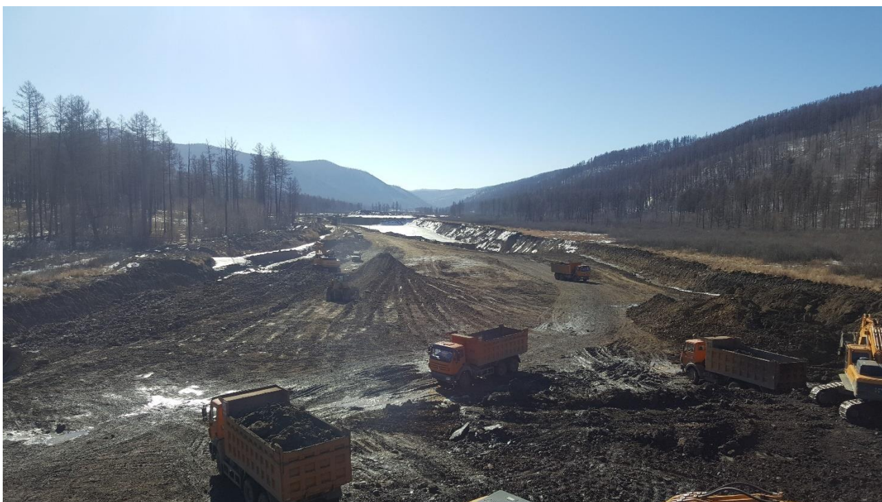
(Зураг № 1 2022 оны уулын ажил явагдаж буй байдал)
