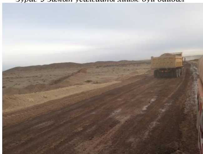
Зураг-3 Замын усалгааны хийж буй байдал
