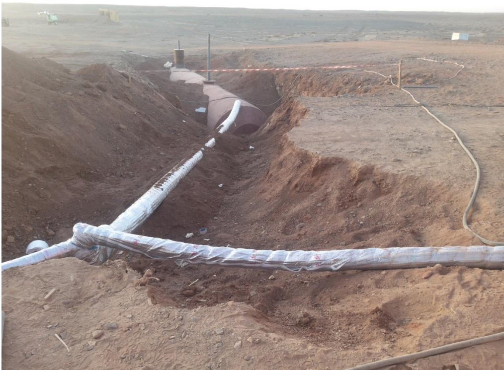
Зураг-11 Зөөврийн бохирын систем суурилуулж буй байдал
