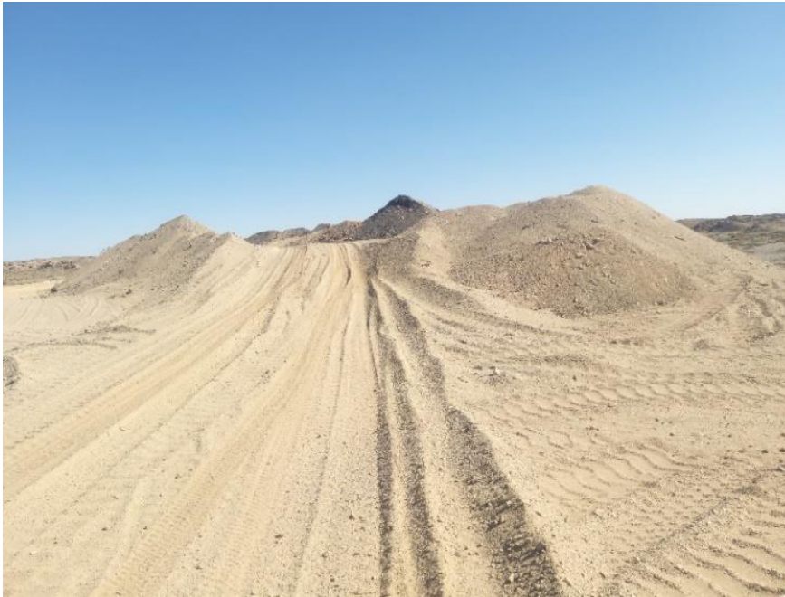
Зураг-4 Шимт хөрсний овоолго үүсгэж буй байдал
