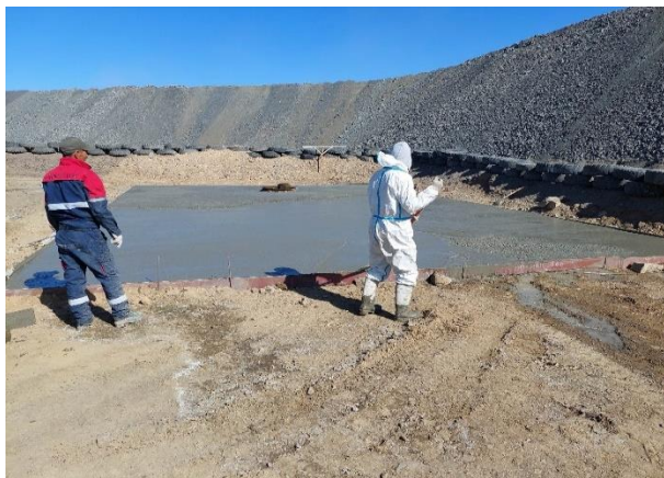
Шатах тослох материалаар бохирдсон хөрс хатаах талбай
