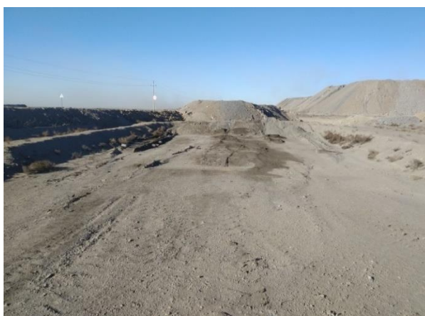
Шатах тослох материалаар бохирдсон хөрс хатаах талбай
