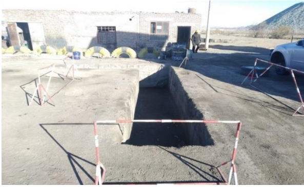
Шатах тослох материалаар бохирдсон хөрс хатаах талбай
