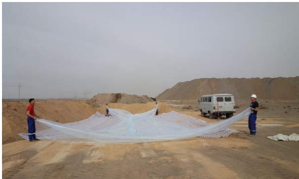
Шатах тослох материалаар бохирдсон хөрс хатаах талбай
