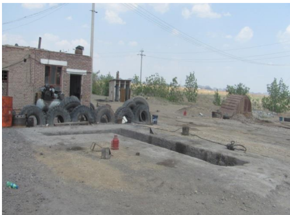
Шатах тослох материалаар бохирдсон хөрс хатаах талбай
