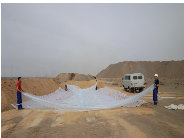
Шатах тослох материалаар бохирдсон хөрс хатаах талбай
