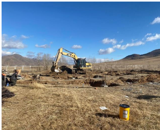
Зураг: 3,4 Ажилчдын хоолны газрын суурь тавигдаж байгаа нь
