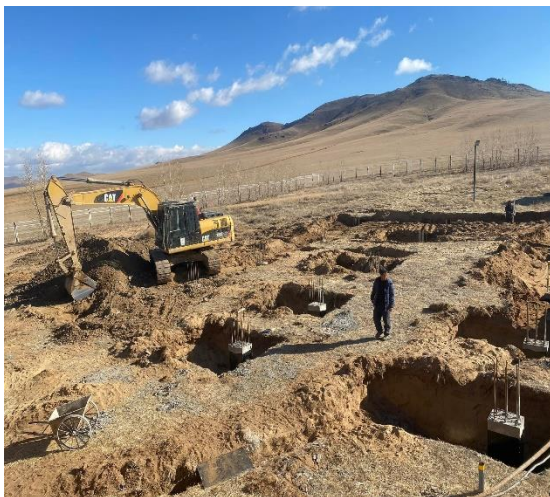
Зураг: 3,4 Ажилчдын хоолны газрын суурь тавигдаж байгаа нь
