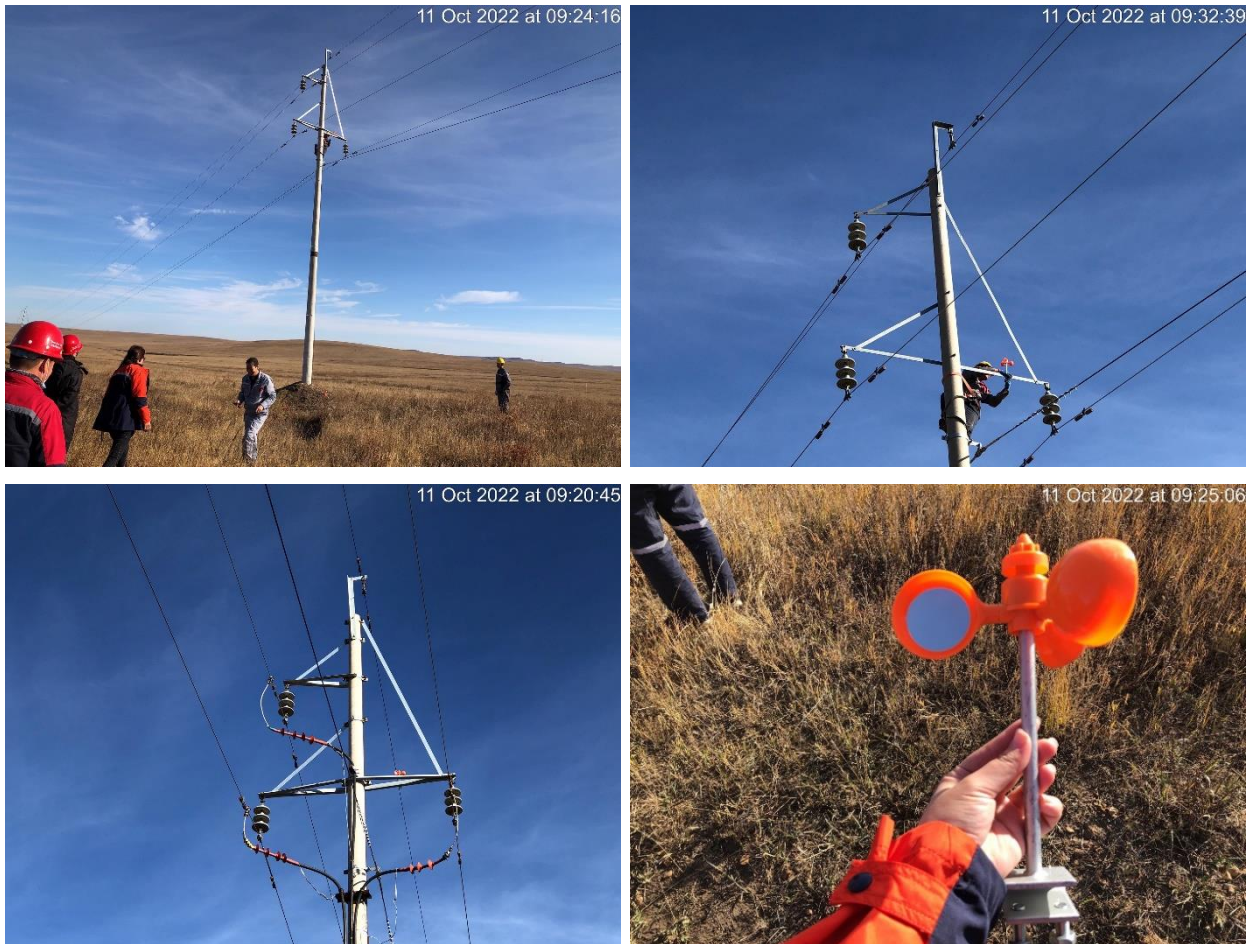
Зураг 62. Шувуу үргээгч толь суурилуулсан байдал
