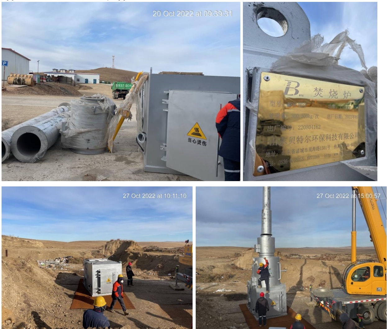
Зураг 56. Хог шатаах зуух суурилуулж байгаа нь
