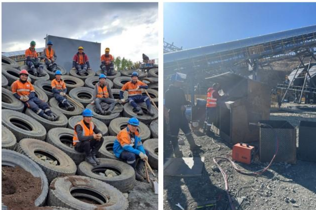
Зураг- 27 Хаягдал дугуйгаар хөрсний гулсалтаас сэргийлэх далан, хаягдал төмөр, лист, турбагаар хогийн сав хийж байгаа байдал
