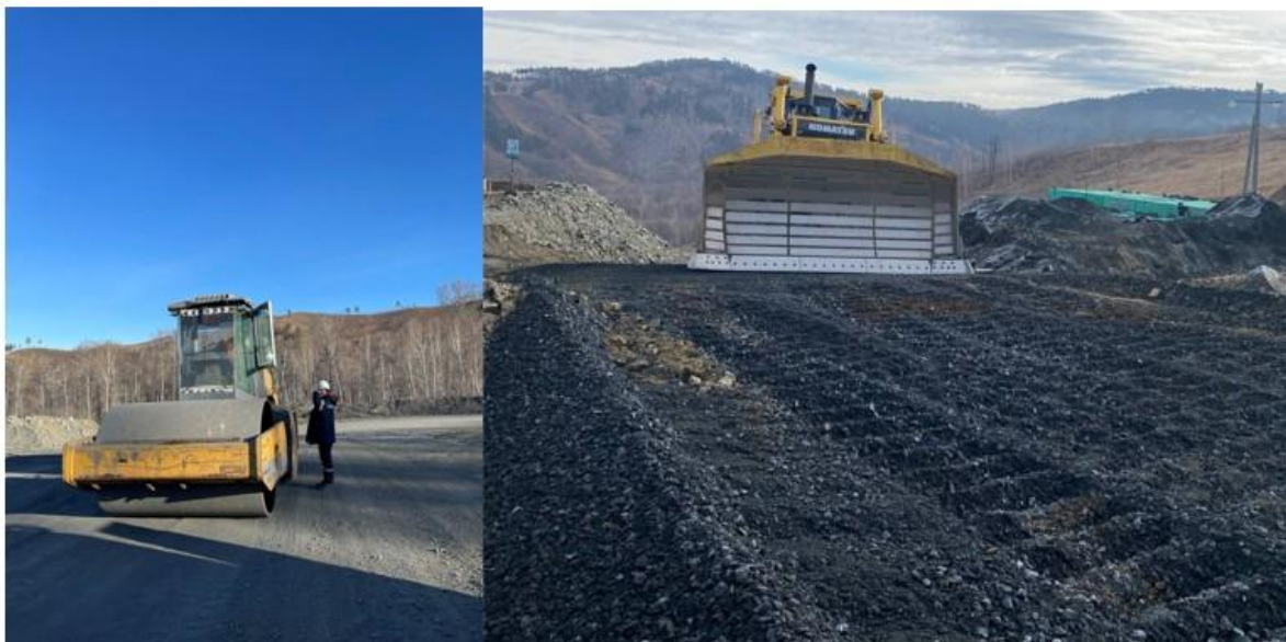
Зураг- 3 Зам талбайг техник хэрэгсэлд тохиромжтой байдлаар засч дагтаршуулж байгаа нь
